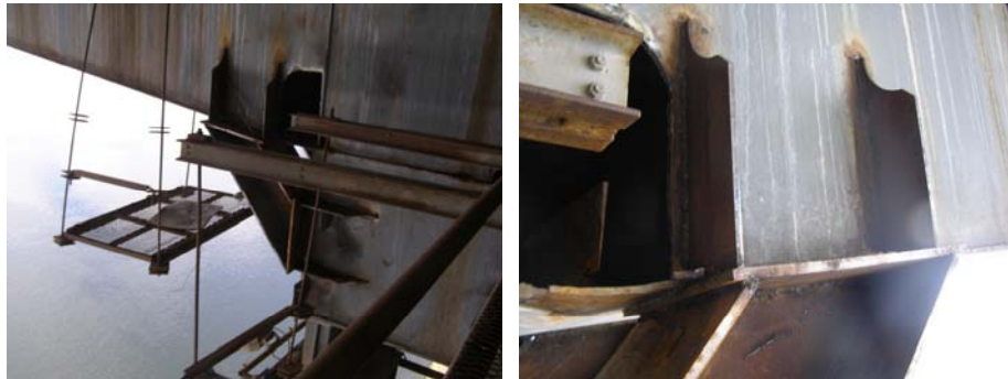
Рис. 4. Усиление нижних поясов металлических несущих ригелей
