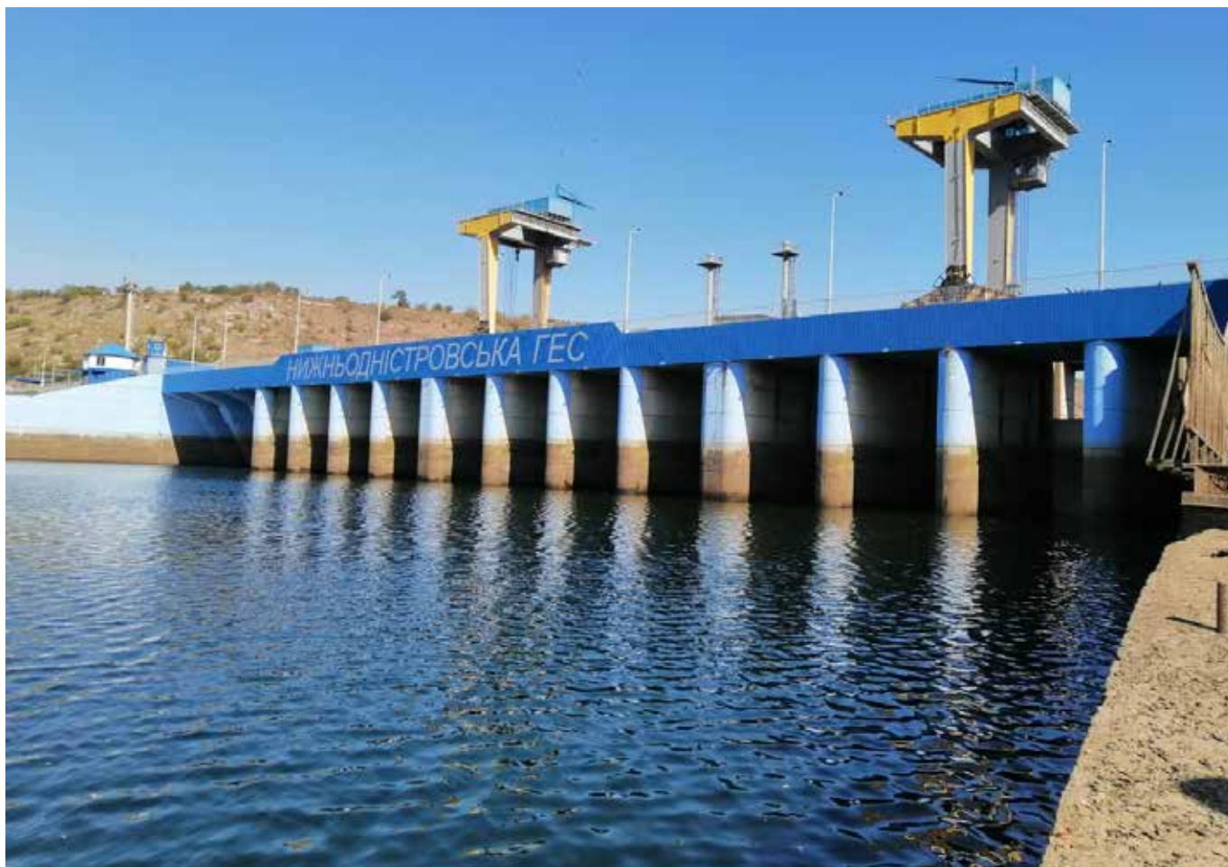
Рис. 2. Загальний вигляд Дністровської ГЕС-2 (Нижньодністровської ГЕС)
