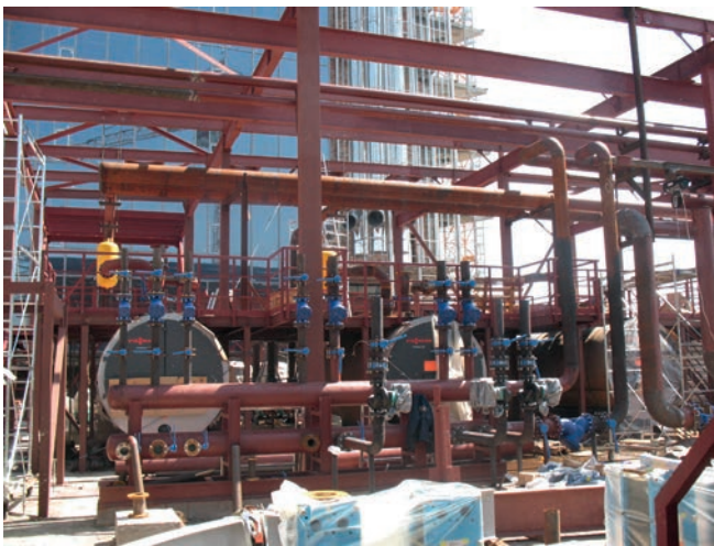
Рис. 16. Проміжні етапи монтажу каркаса котельні
