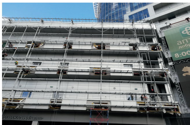
Рис. 41. Проміжний етап монтажу тримальних металокаркасів фасадних відеоекранів
