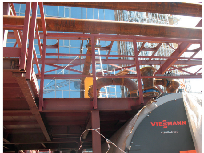
Рис. 16. Проміжні етапи монтажу каркаса котельні
