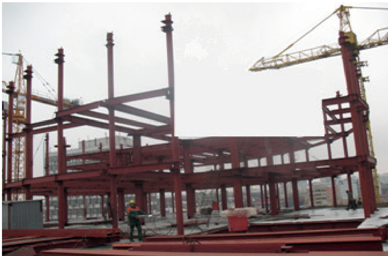
Рис. 21. Проміжний етап монтажу каркаса офісної надбудови
