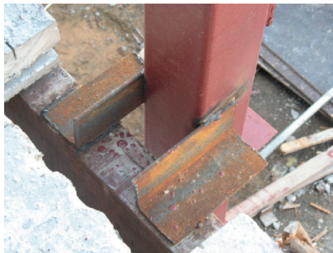
Рис. 11. Фрагменти монтажу фахверкових стійок
