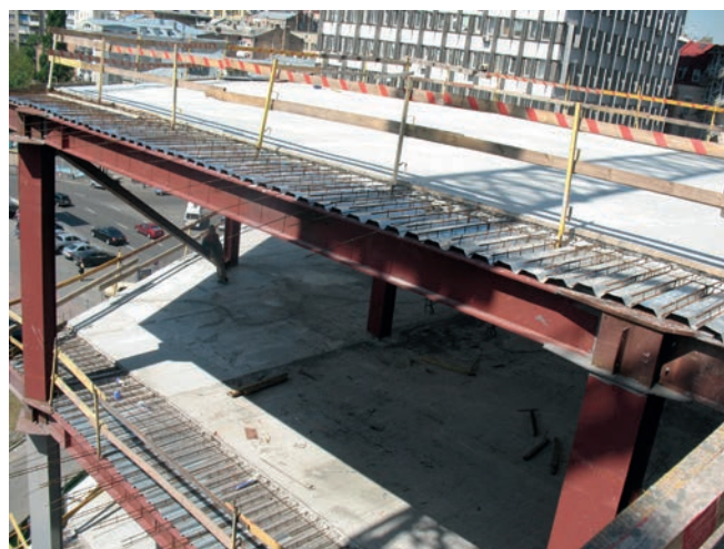
Рис. 36. Проміжні етапи монтажу каркаса передньої частини будівлі ТРЦ в осях 1а/1 — 1; Е — Л: а — монтування металевих конструкцій; б — монтування ферм; в — фрагмент каркаса із монолітною залізобетонною плитою перекриття
