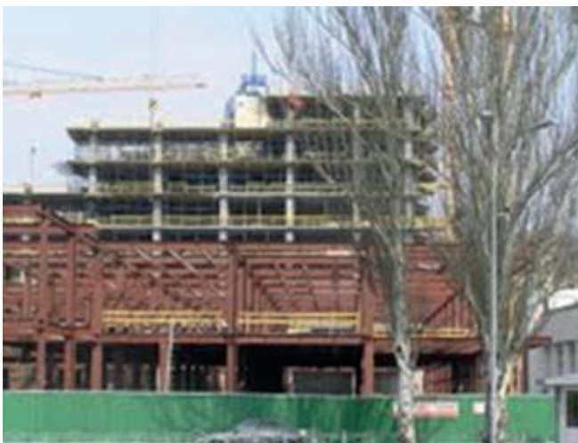
Рис. 7. Загальний вигляд будівлі ТРЦ із боку Спортивної площі у процесі будівництва
