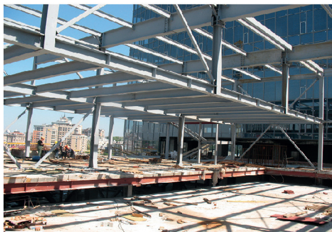
Рис. 27. Проміжний етап монтажу каркаса надбудови над басейном (а) і загальний вигляд фасаду фітнес клубу «Sky Fitness» (б)
