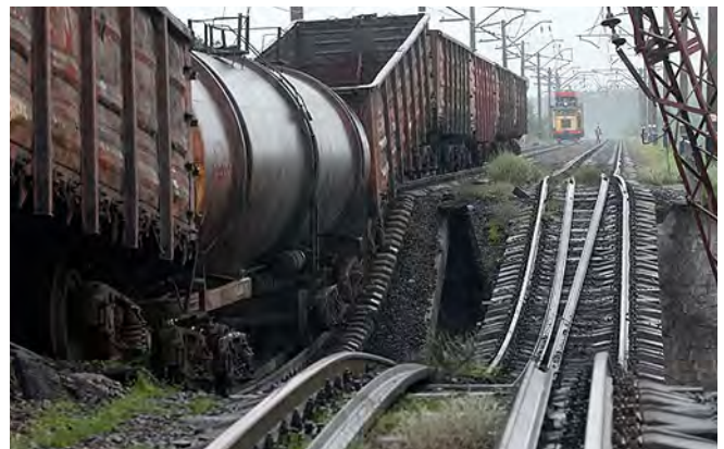
Рис. 3. Руйнування конструкцій залізничного мосту від дії повітряної ударної хвилі
