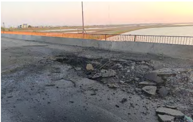
Рис. 2. Руйнування конструкцій шосейного мосту від механічного впливу вражаючих елементів
