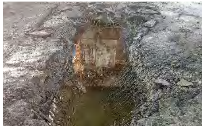
Рис. 2. Руйнування конструкцій шосейного мосту від механічного впливу вражаючих елементів
