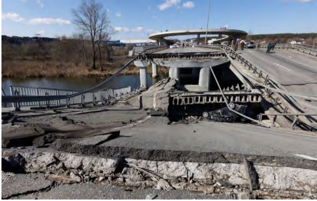
Рис. 1. Руйнування конструкцій шосейного мосту від дії повітряної ударної хвилі
