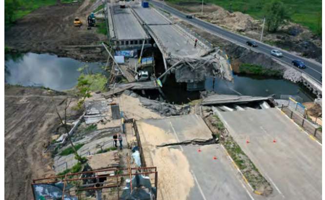
Рис. 1. Руйнування конструкцій шосейного мосту від дії повітряної ударної хвилі
