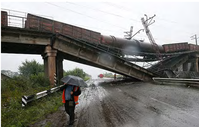
Рис. 3. Руйнування конструкцій залізничного мосту від дії повітряної ударної хвилі
