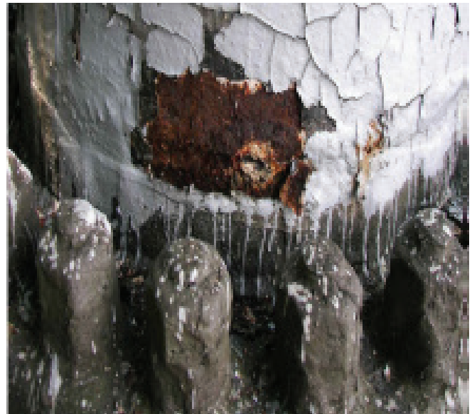
Рис. 10. Пошкодження опорних частин несних конструкцій
