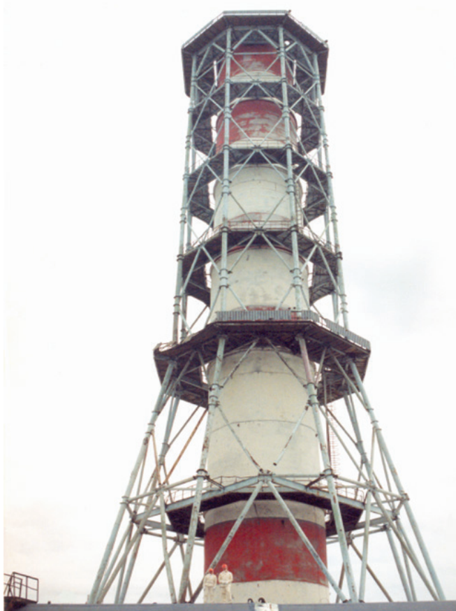
Рис. 8. Вентиляційна вежа-димар 3-го і 4-го енергоблоків Чорнобильської АЕС (знімок зроблений у 1996 р. під час обстеження вежі-димаря)
