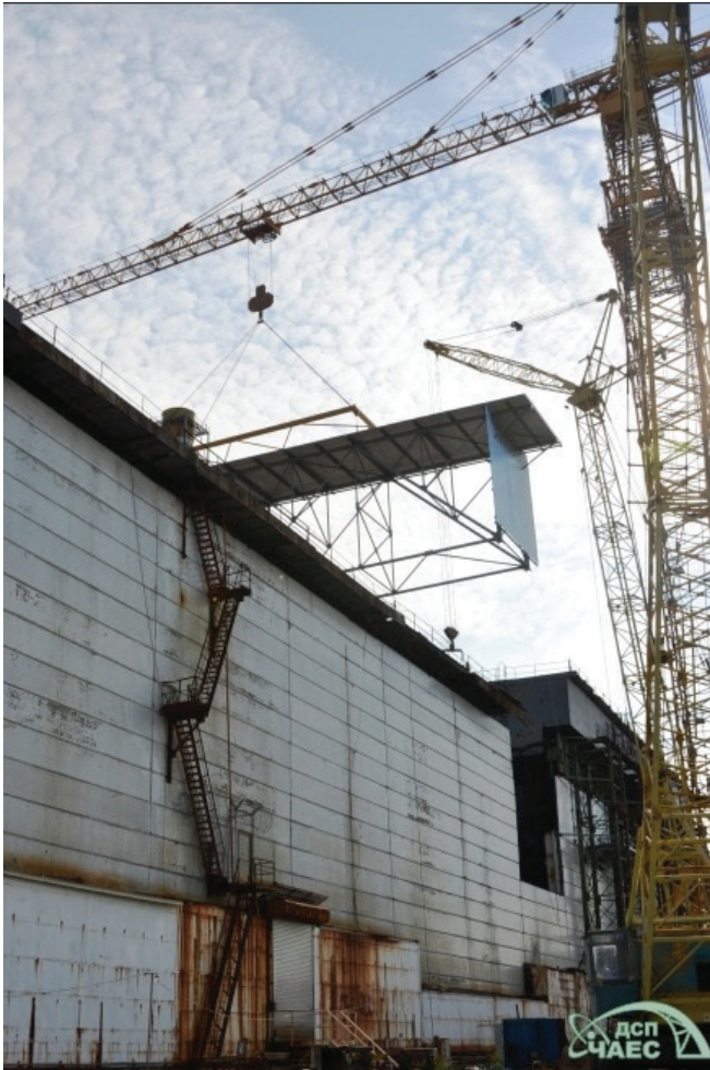
Рис. 11. Монтаж блока покриття машинної зали
