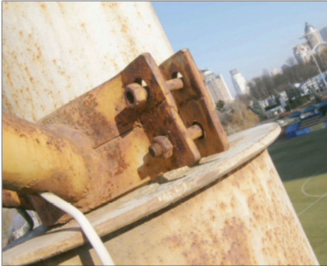
Рис. 9. Стан конструкцій у вузлових з'єднаннях: а — елементи конструкцій; б — стикове з'єднання
