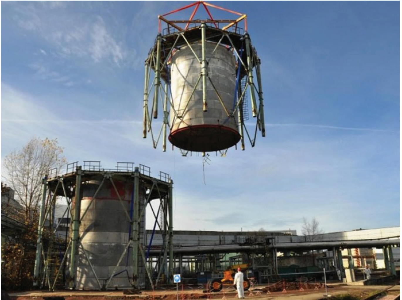
Рис. 9. Демонтаж вентиляційної вежі-димаря
