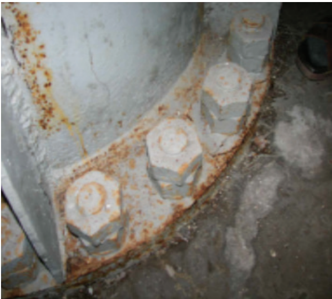
Рис. 10. Пошкодження опорних частин несних конструкцій
