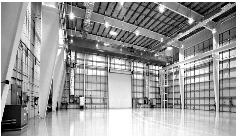
Рис. 1.2. Виробнича будівля рамного типу, обладнана кран-балкою
