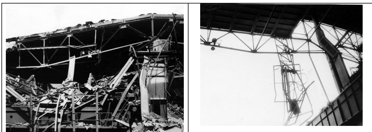
Рис.2.6. Аварійне обвалення покриття
