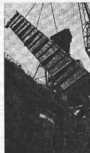
Рис. 10.4. Пространственный блок моста открытого типа в стадии монтажа
