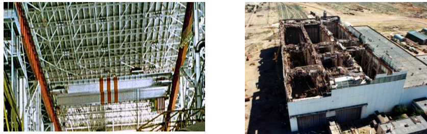
Рис. 4.5. Обвалення даху МБК на космодромі Байконур:
