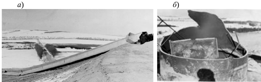
Рис. 4.11. Руйнування обеліска (Корсунь-Шевченківський): а - обеліск, що зруйнувався; б – місце зламу
