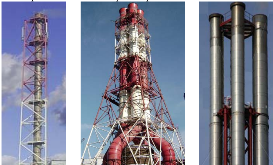
Рис. 6.19. Конструктивные решения стальных вытяжных труб
