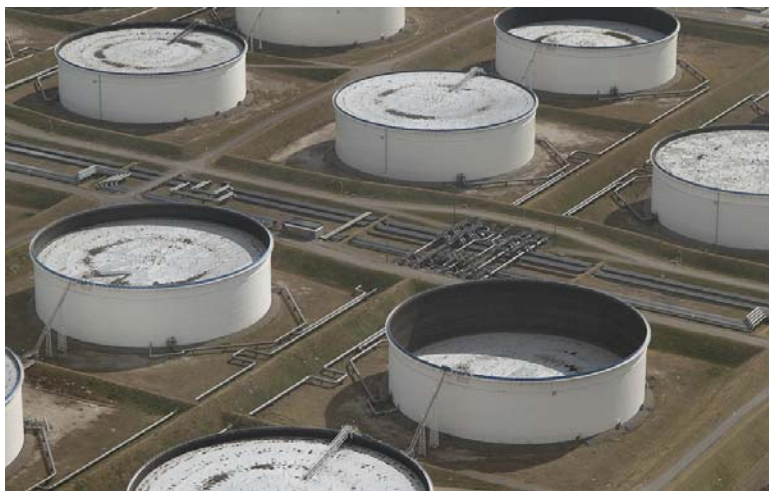
Рис. 8.12. Нефтехранилище в порту близ Роттердама
