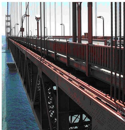
Рис. 9.20. Фермы жесткости
