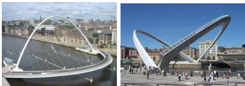
Рис. 3.53. Гейтсхедский Millenium Bridge
