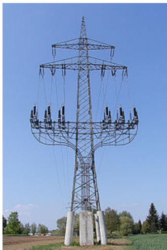
Рис. 6.29. Специальная опора — переход к подземной кабельной линии
