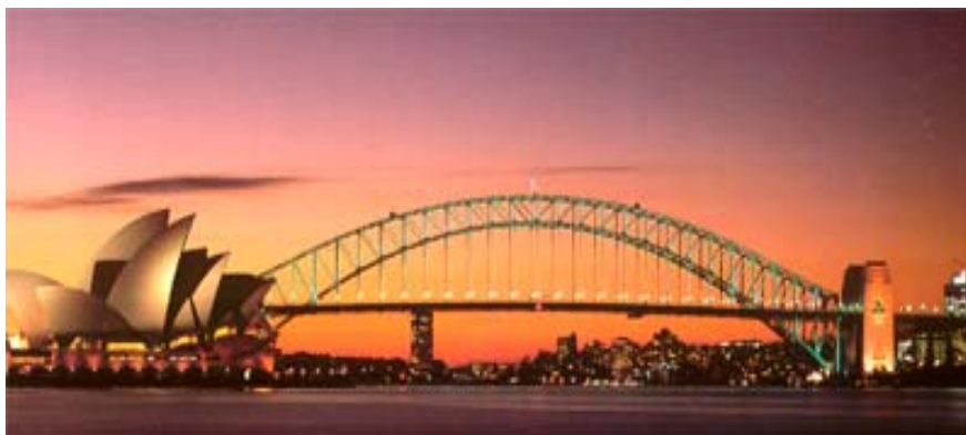
Рис. 3.29. Мост через Сиднейскую Гавань
