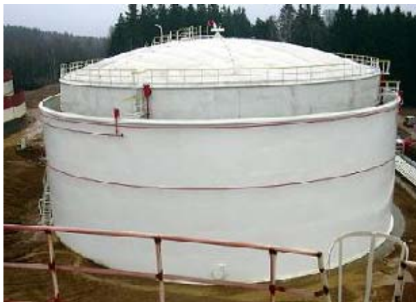
Рис.8.13. Резервуар с двойными стенками
