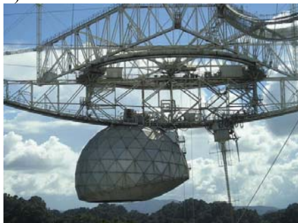
Рис. 7.16. Радиотелескоп в Аресибо: а – общий вид; б - облучатель
