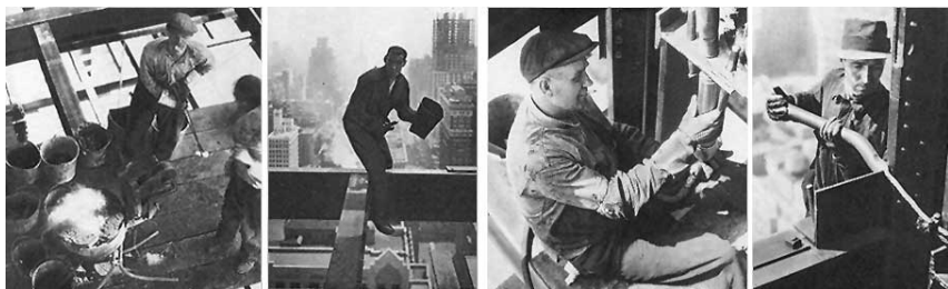
Рис. 1.17. Бригада клепальщиков: слева направо — «повар», «вратарь», «упор» и «стрелок»
