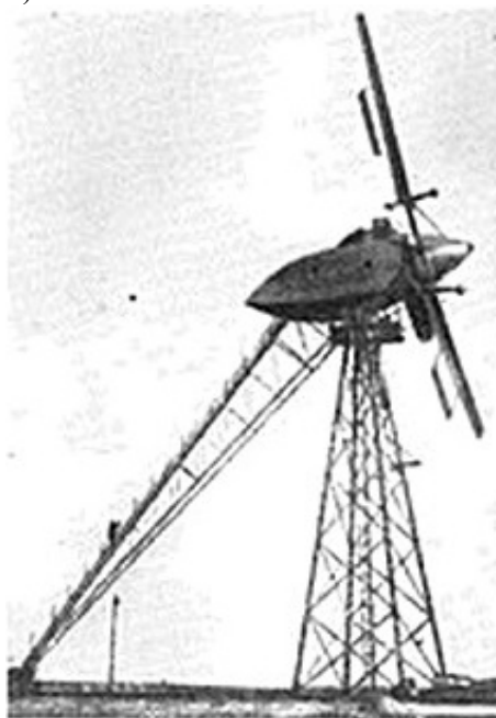
Рис. 6.5. Разработки Ю.Кондратюка: а – ВЭУ ЦАГИ в Балаклаве, б - проект ВЭУ на горе Ай Петри
