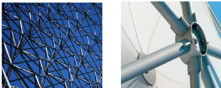
Рис. 9.33. Модульные элементы и конструкция узлового соединения
