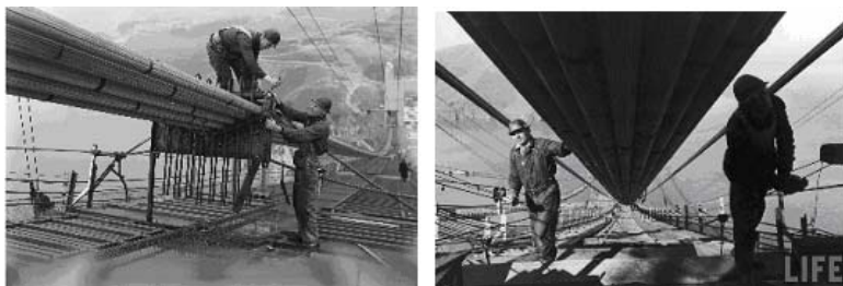
Рис. 9.21. Сборка кабеля из прядей
