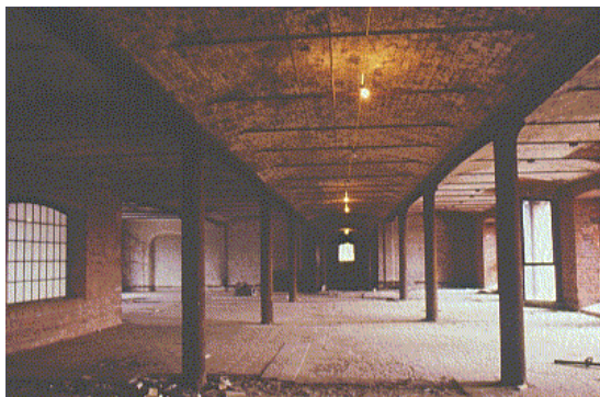
Рис. 4.15. Старинное здание с чугунными колоннами и балками
