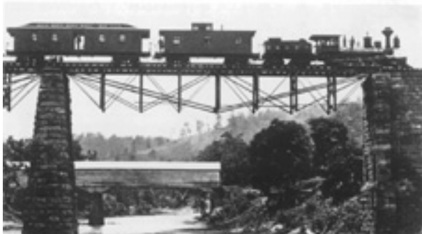
Рис. 3.11. Ферма Виппла на испытаниях
