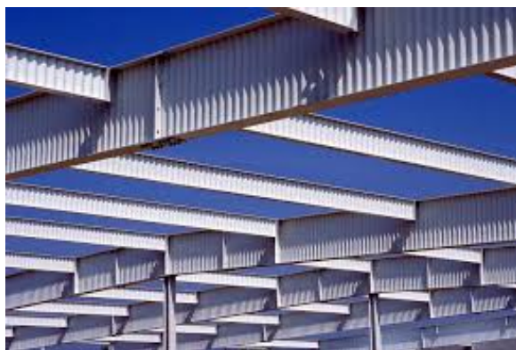
Рис. 2.16. Конструкция с использованием Sin-балок
