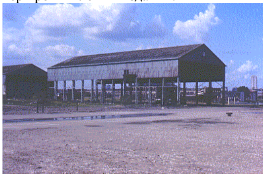
Рис. 4.17. Складское здание с ограждениями из рифленого железа
