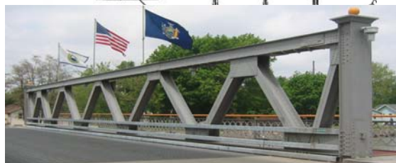
Рис. 3.15. Ферма Уоррена: а – рисунок из патента Уоррена и Монзани, б – мост с ездой понизу
