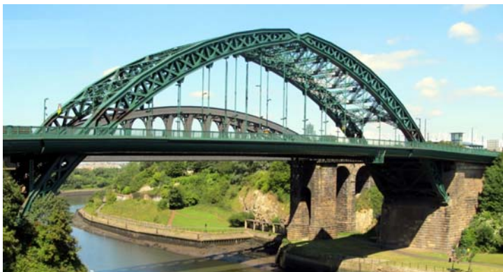
Рис. 3.3. Мост через Вер в Уирмаусе
