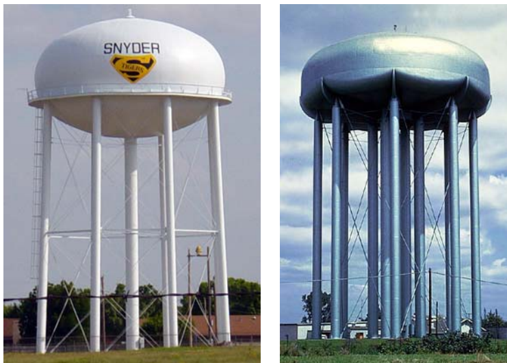
Рис. 8.7. Современные водонапорные башни
