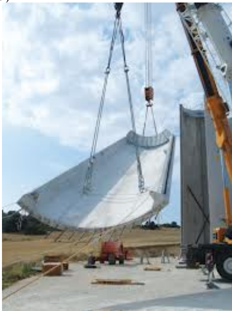
Рис 6.15 Новые конструктивные решения башен ВЭУ большой высоты
