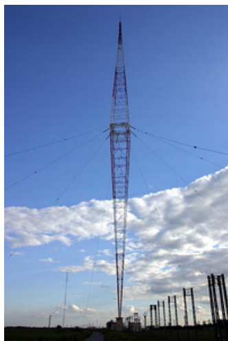
Рис. 5.17. Мачты с неклассическим стволом: а – переменного сечения, б – усиленным шпренгелем
