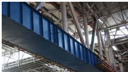
Рис. 4.27. Подкраново-подстропильная ферма
