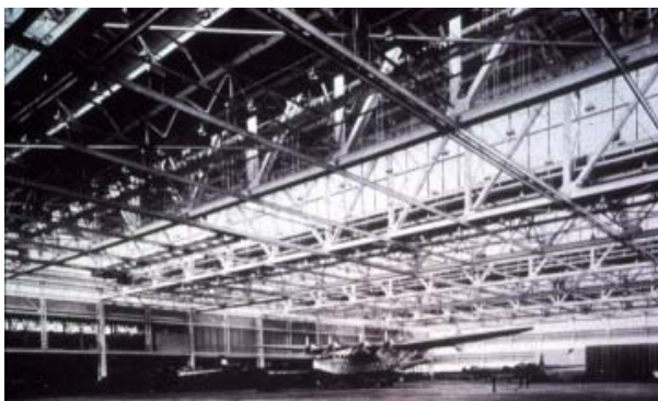
Рис. 4.25. Здание сборочного цеха авиакомпания Glenn Martin
