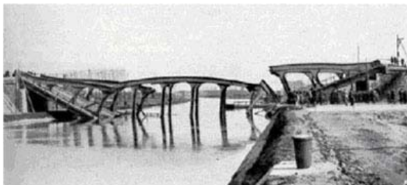
Рис. 3.47. Авария моста через канал Альберта
