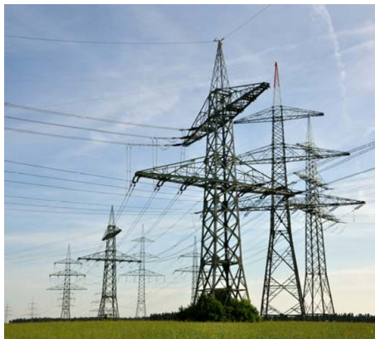
Рис. 6.30. Специальная опора — пересечение воздушных линий
