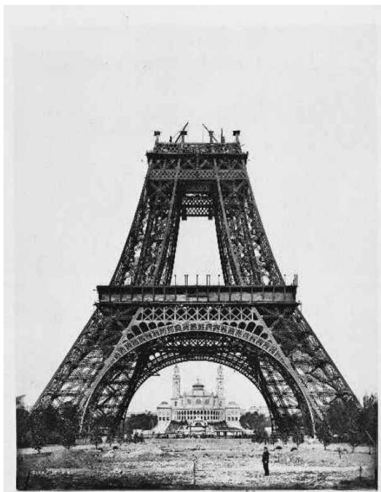
Рис. 9.7. Башня в процессе монтажа
