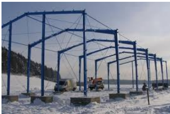
Рис. 2.13. Каркас из двутавров переменного профиля
