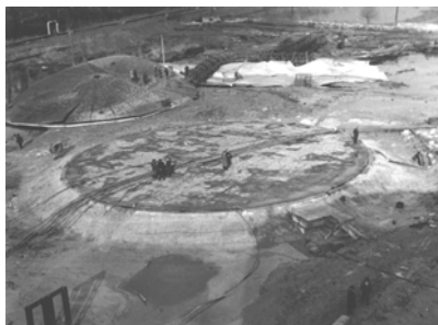
Рис. 8.25. Разрушение резервуара №3: а – отброшены купол и стенка резервуара № 3; б – на старом месте осталось только днище резервуара № 3
