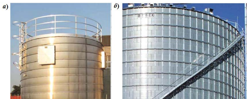
Рис. 8.8. Силосы для хранения зерна: а - оцинкованный стальной спирально-фальцевый силос; б - стальной силос болтовой сборки из листовой гофрированной стали
