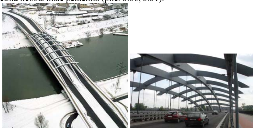
Рис. 3.30. Котлярский арочный мост в Кракове, пролет 166 м
