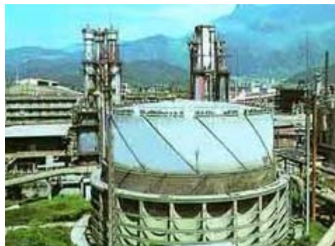
Рис. 8.19. Винтовой газгольдер емкостью 165\,000\text{ м}^3
