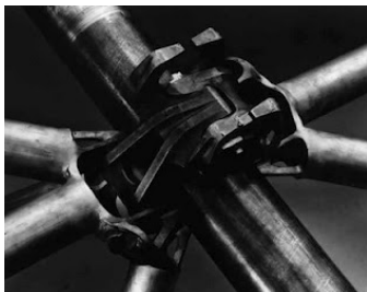
Рис. 4.42. Узел системы Wachsmann
