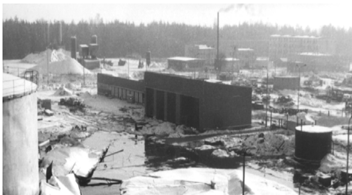
Рис. 8.22. Разрушение при испытаниях наливом воды
