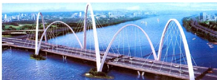
Рис. 3.31. Автодорожный мост в Южном Китае
