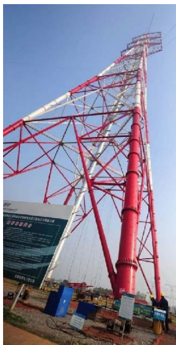
Рис. 6.37. Переходная опора через Янцзы.
