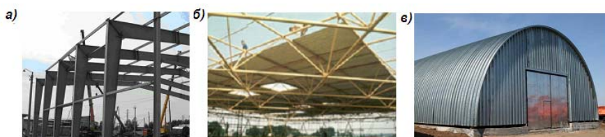
Рис. 4.38. Типичные здания из легких металлоконструкций
