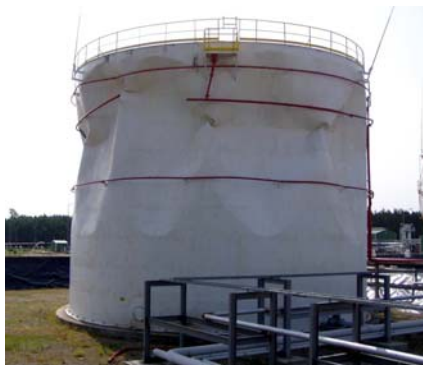
Рис. 8.26. Потеря устойчивости под действием внутреннего вакуума
