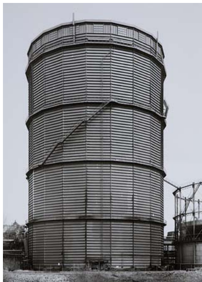
Рис. 8.20. Сухой газгольдер: схема и общий вид
