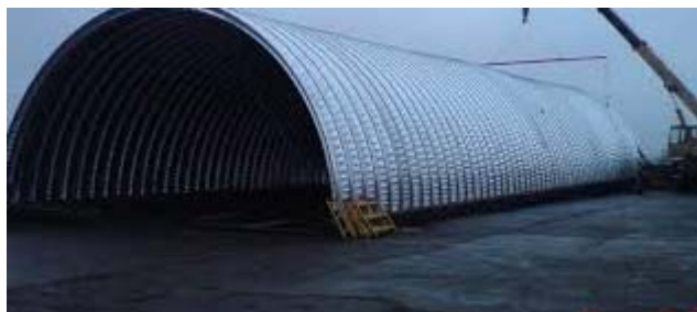
Рис. 4.45. Арочная конструкция склада
