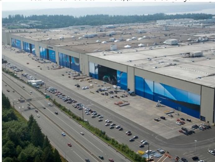
Рис. 9.36. Общий вид здания в Эверетте
