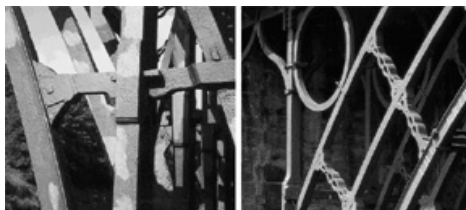
Рис. 1.14. Соединения чугунных элементов моста
