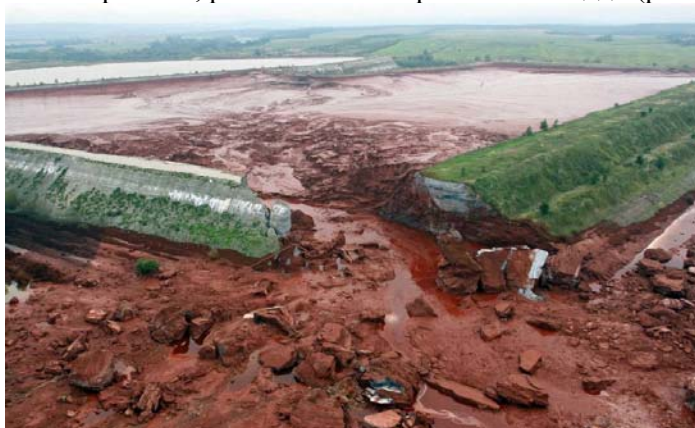
Рис. 8.27. Разрушение обвалования
