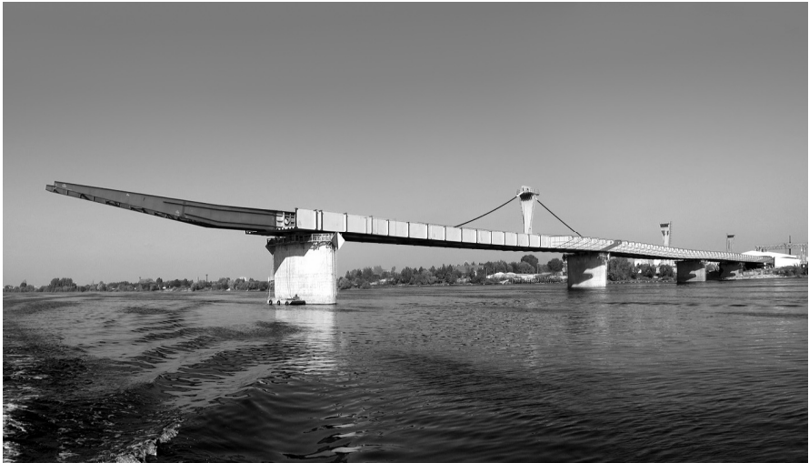
Рис. 2.17. Надвигка пролётного строения моста в Риге
