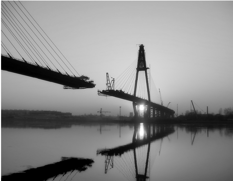
Рис. 2.16. Сооружение вантового моста через Неву в Санкт-Петербурге
