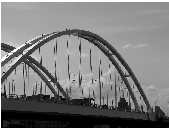
Рис. 11.10. Арочный мост в Астане – вид сбоку.
