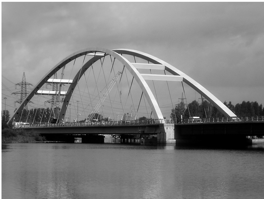
Рис. 2.15. Арочный мост через р. Охта в Санкт-Петербурге
