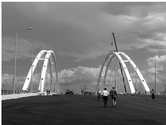
Рис. 11.9. Арочный мост в Астане – вид вдоль проезжей части.
