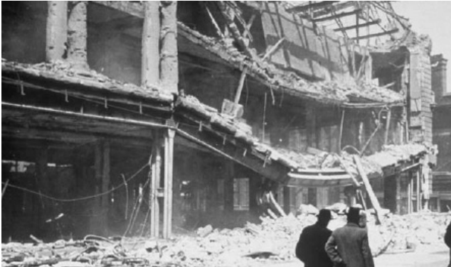
Рис. 11.6. Деформации поврежденного каркаса
