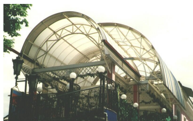
Рис. 5.23. Поддерживающие конструкции навеса
