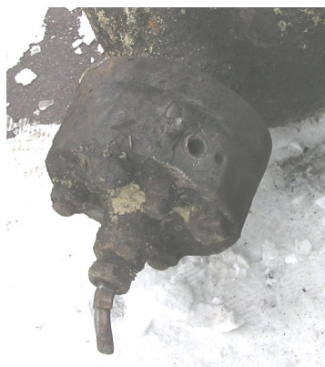
Рис. 5.35. Фланцевое соединение с крепежными болтами и технологическим отверстием
