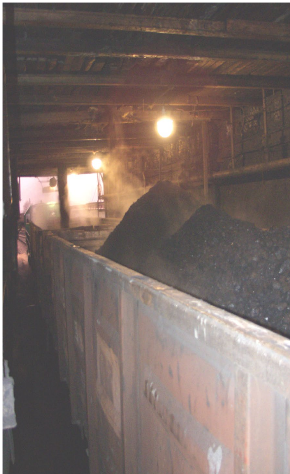
Рис. 1.1. Здание углеподготовки обогатительной фабрики
