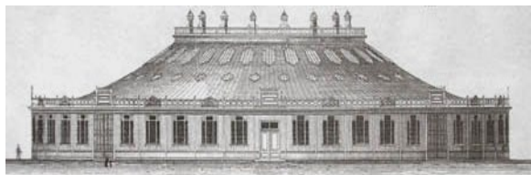
Рис. 1.4. Павильон с висячим покрытием в г. Нижнем Новгороде
