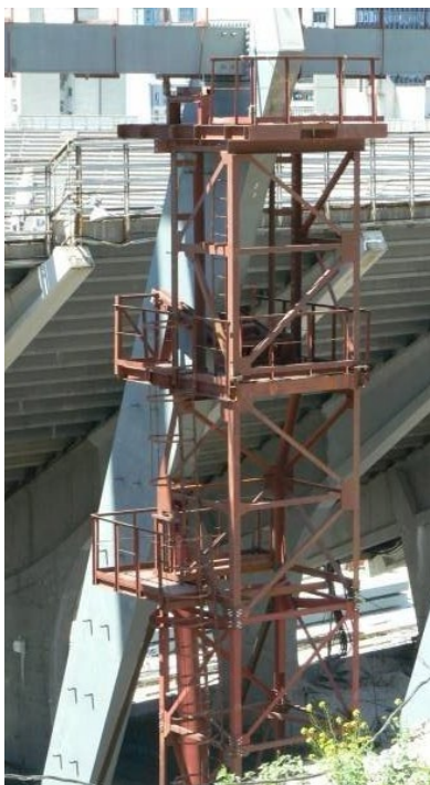
Рис. 12.55. Переставные башни для установки колонн в проектное положение и регулировки их геометрии
