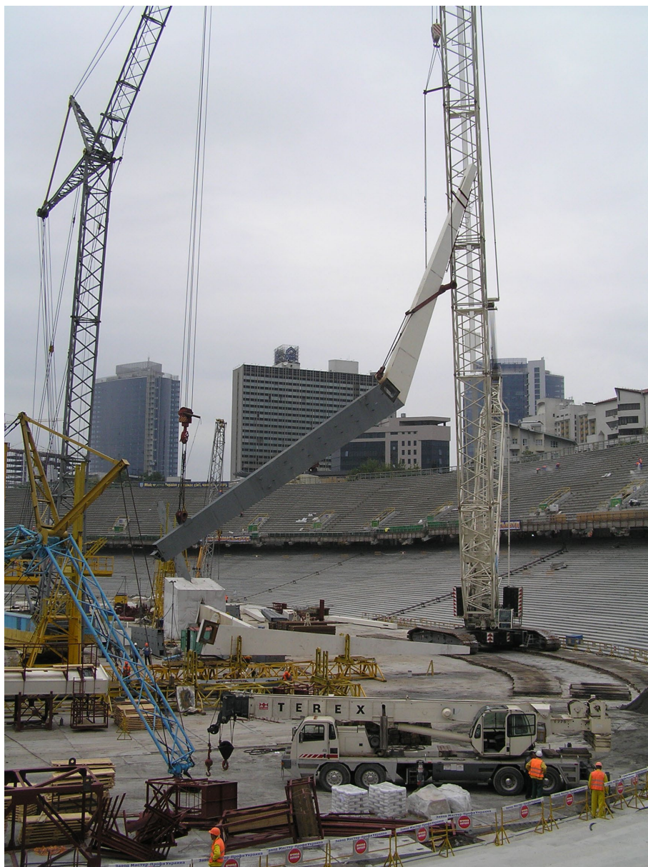
Рис. 12.57. Монтаж колонны кранами Demag CC 2800-1 и СКГ-100
