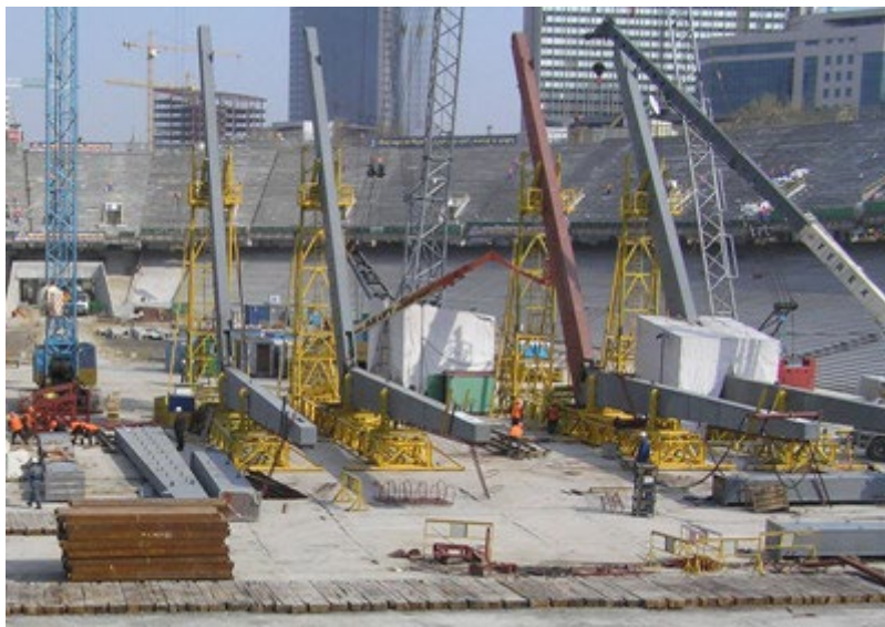
Рис. 12.54. Общий вид стендов для укрупнительной сборки колонн на монтажной площадке
