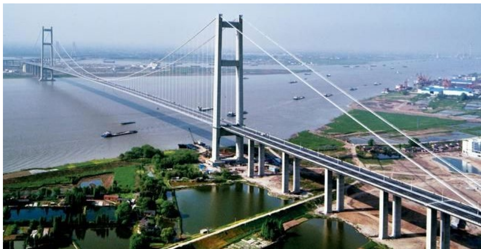
Рис. 1.6. Общий вид висячего моста Жуньян через реку Янцзы
