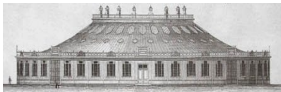
Рис. 1.10. Павильон с висячим покрытием в г. Нижнем Новгороде
