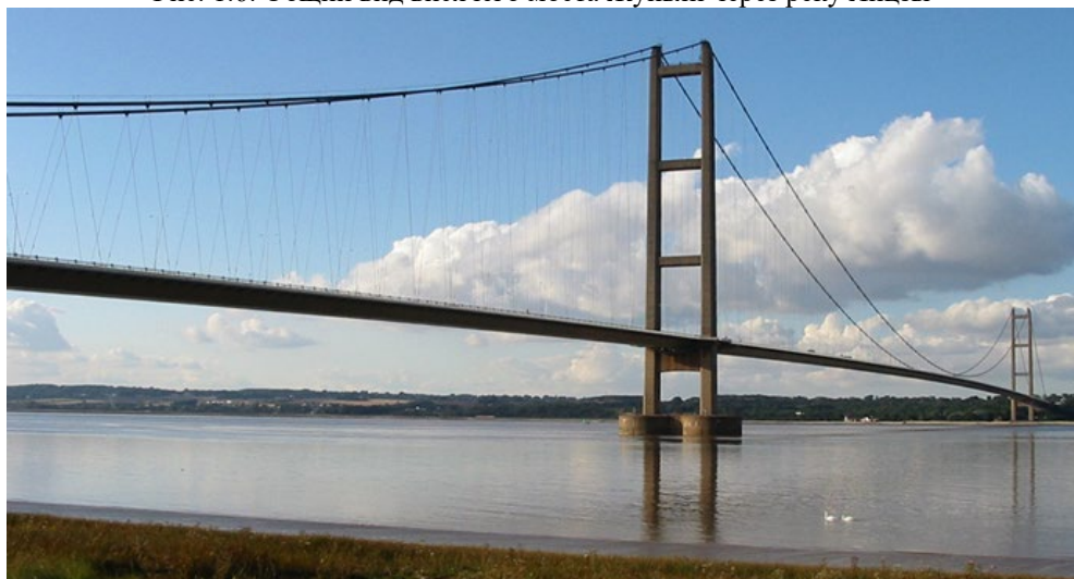
Рис. 1.7. Общий вид висячего моста Хамбер через Хамберский эстуарий рек Трент и Уз
