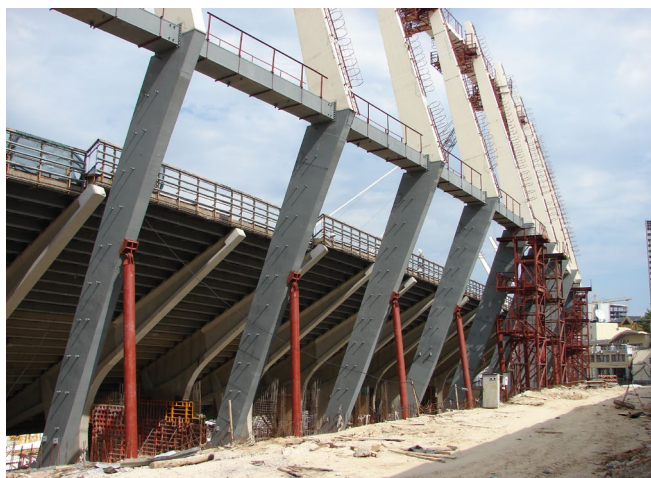
Рис. 12.56. Подпорки под колонны на время монтажа
