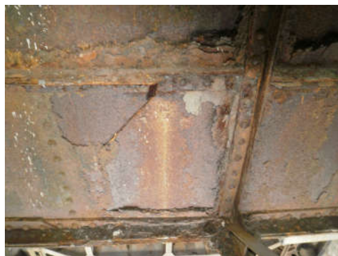
Рис. 3.3. Корозія головної балки у прогоні № 8-9
