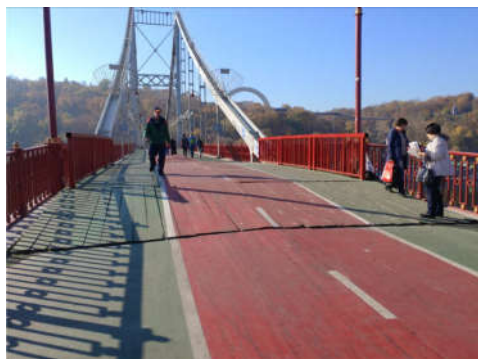
Рис. 9.12. Тимчасовий настил на блоках противаг, влаштований до моменту ліквідації аварійної ситуації на мосту
