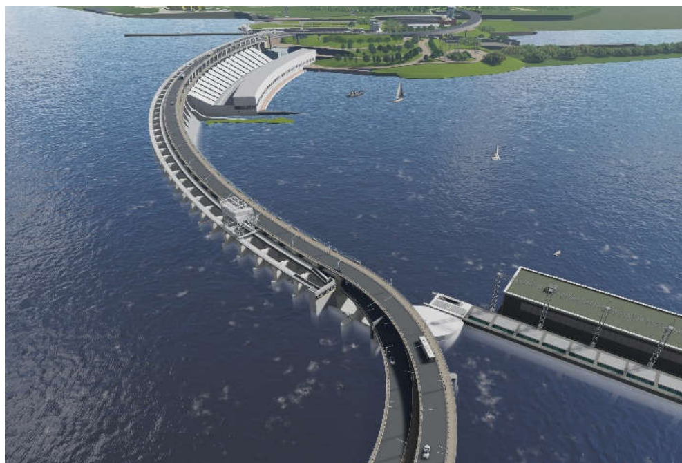
Рис. 2.43. Вид зверху мостових споруд по греблі з боку мосту через аванкамеру
