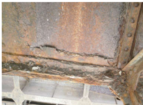
Рис. 1.31. Виразкова корозія стінки та поясу головної балки
