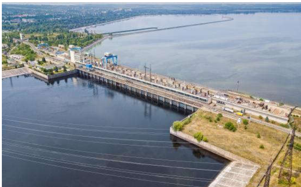
Рис. 12.1. Загальний вигляд Канівської ГЕС
