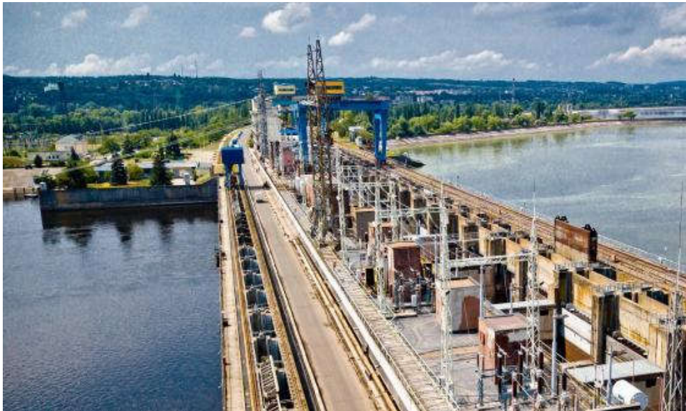
Рис. 12.2. Автдорожний перехід по греблі Канівської ГЕС
