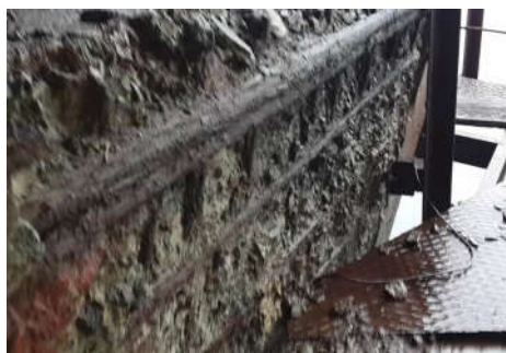
Рис. 6.6. Руйнування консольних частин ригелів опор (а) і видавлювання фторопласту з опорних частин (б)
