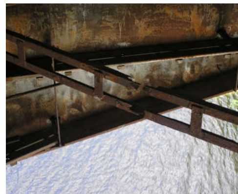
Рис. 4.6. Розрив в'язі в прогоні 16 – 17 внаслідок дії корозії
