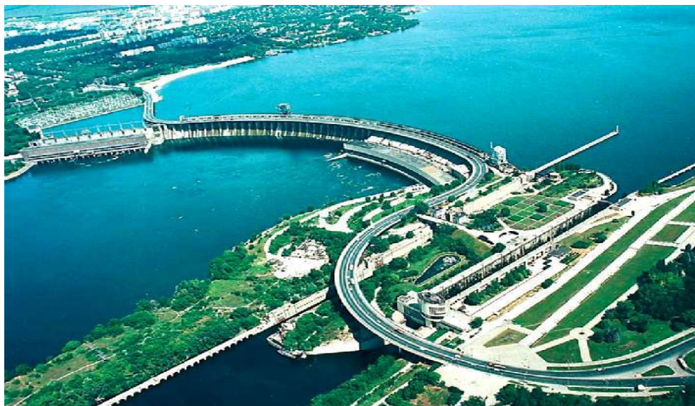
Рис. 1.1. Загальний вигляд автодорожнього переїзду через споруди греблі ДніпроГЕС
