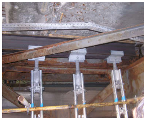
Рис. 3.5. Тимчасові додаткові металеві балки, обперті на колони підвищеної навантаги: а – загальний вигляд; б – вузол обпирання
