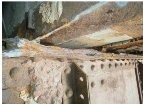
Рис. 1.29. Роздуття та щілинна корозія верхнього поясу головної балки
