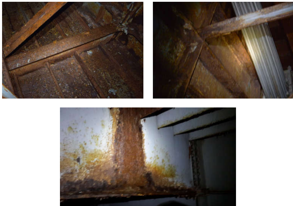
Рис. 6.4. Корозія металу у вантових прогонах
