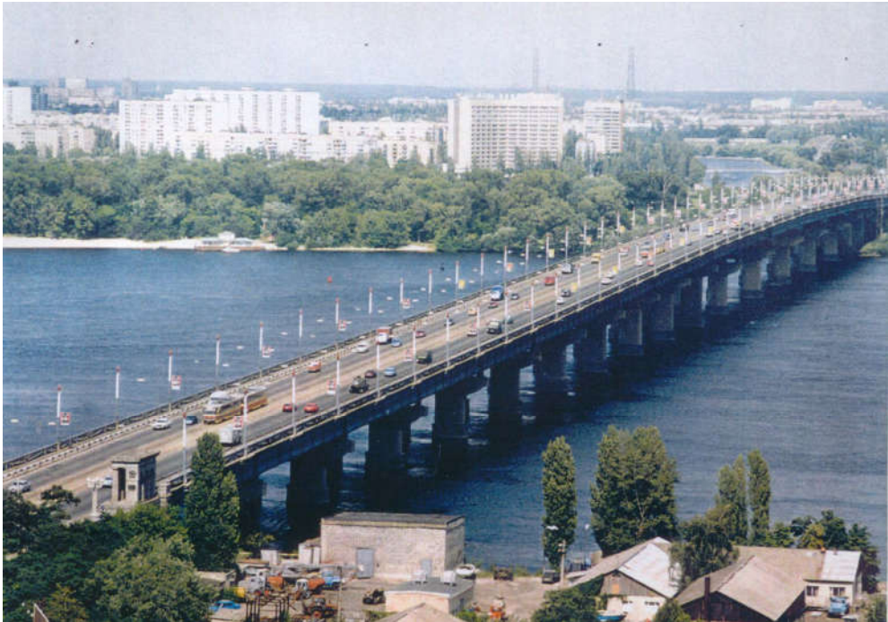
Рис. 2.1. Загальний вигляд моста ім. Є.О. Патона
