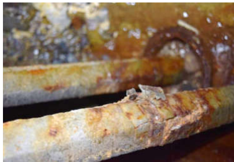
Рис. 6.5. Корозія металу трубчастих обойм і пошкодження металострічки канатів вантів
