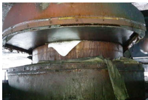
Рис. 6.6. Руйнування консольних частин ригелів опор (а) і видавлювання фторопласту з опорних частин (б)
