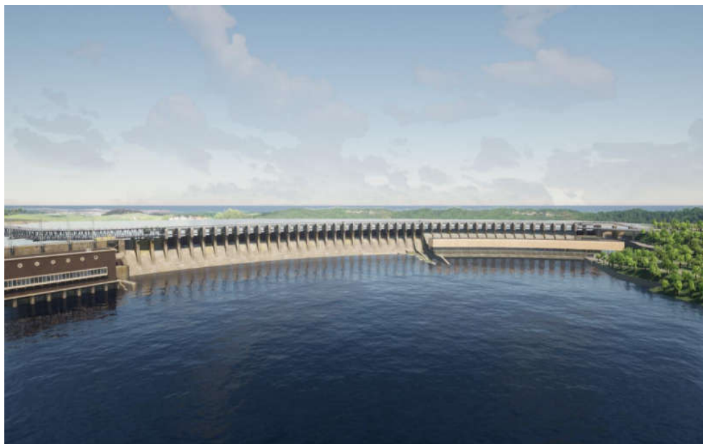
Рис. 2.26. Загальний вигляд нового чотирисмугового автодорожнього проїзду за другим концептуальним варіантом реконструкції з застосуванням збірно-монолітних залізобетонних конструкцій (вид з нижнього б'єфа)
