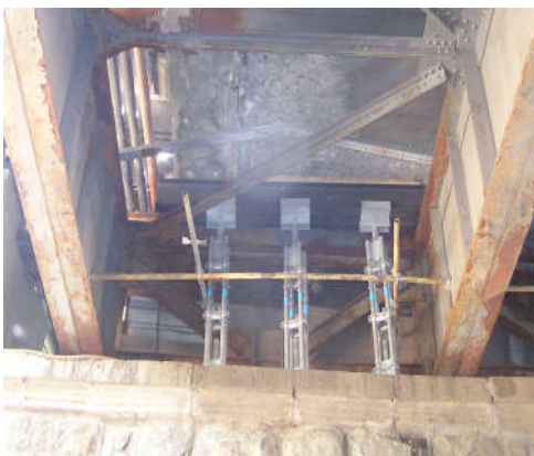
Рис. 3.5. Тимчасові додаткові металеві балки, обперті на колони підвищеної навантаги: а – загальний вигляд; б – вузол обпирання
