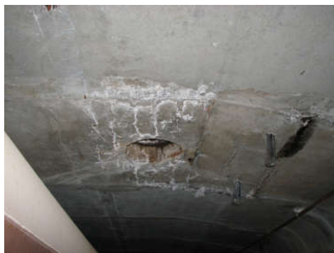
Рис. 3.4. Вилуговування бетону елементів залізобетонних прогонових будов
