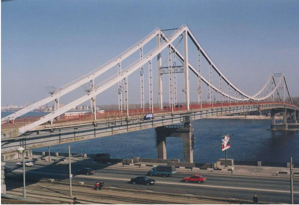
Рис. 7.1. Загальний вигляд Паркового пішохідного моста через р. Дніпро в м. Києві
