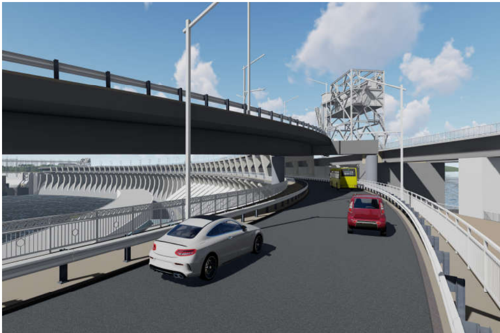
Рис. 2.49. Вид на проїзну частину мостової споруди нижнього ярусу на ділянці сполучення із земляною вставкою
