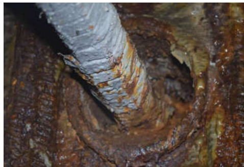
Рис. 6.5. Корозія металу трубчастих обойм і пошкодження металострічки канатів вантів
