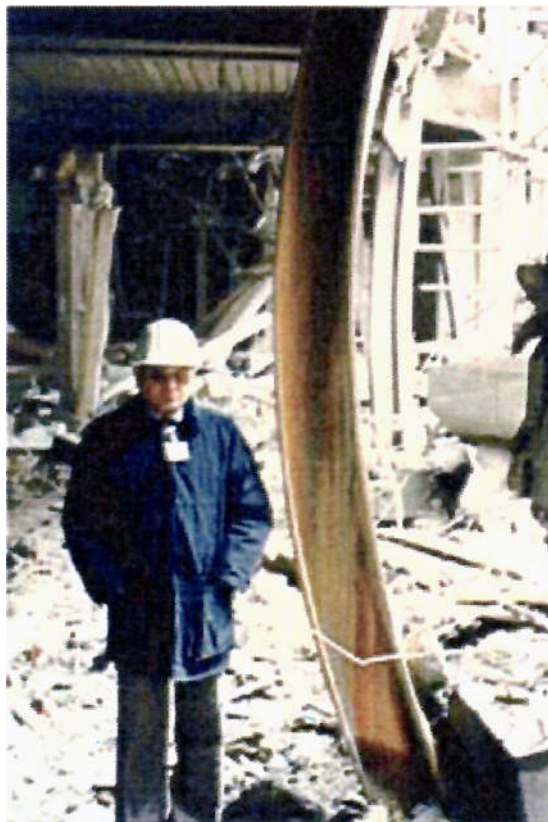
Рис. 2.2. Деформація колони від впливу вибухової хвилі
