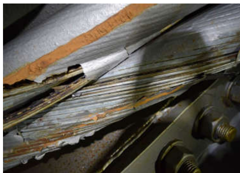
Рис. 2.7. Руйнування і обриви дротин канатів вант
