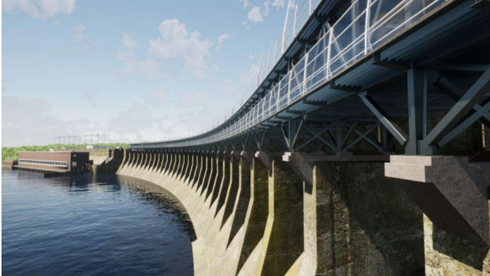
Рис. 2.14. Загальний вигляд нового двоярусного автодорожнього проїзду за третім концептуальним варіантом реконструкції з застосуванням металевих конструкцій (вид із лівого берега р. Дніпро з боку нижнього б'єфу)
