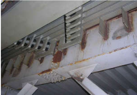
Рис. 4.9. Поверхнева корозія поперечних балок внаслідок термічного впливу зварювання
