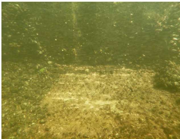
Рис. 3.7. Обростання біологічними організмами всієї поверхні підводної частини тіла та ростверку опори № 5.
