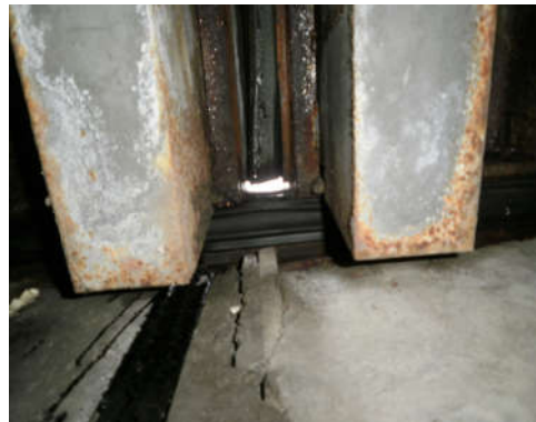
Рис. 1.18. Відсутність з'єднання поперечного та поздовжнього неопренових компенсаторів
