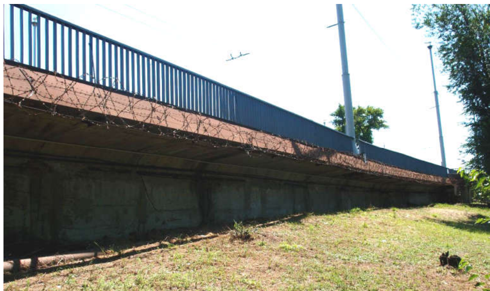
Рис. 1.52. Фрагмент підпірної стінки № 6 земляної вставки в межах секцій С 5 – С 4
