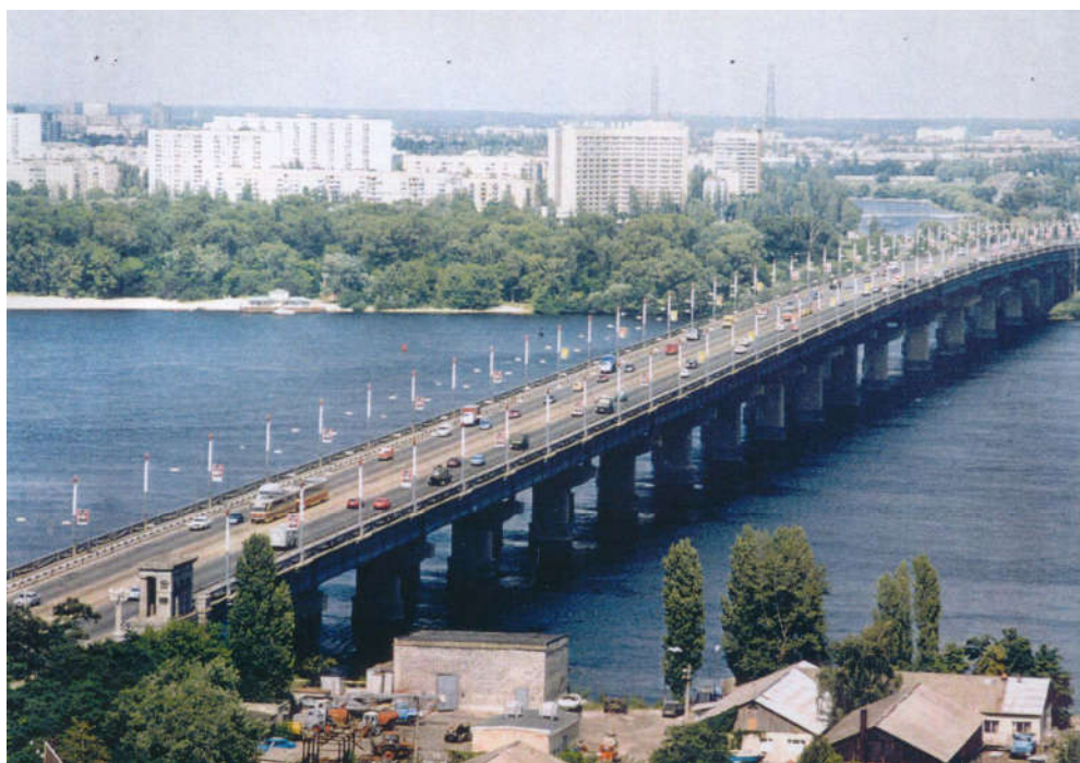
Рис. 1.1. Загальний вигляд моста ім. Є.О. Патона
