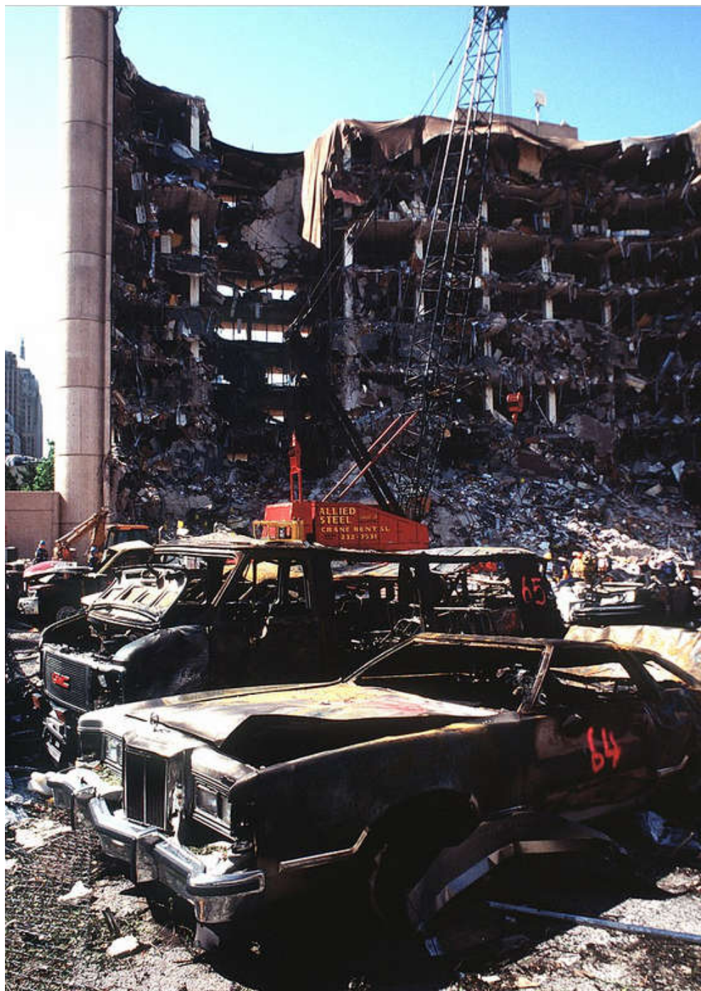
Рис. 1.4. Зруйнована будівля імені Альфреда Марра в м. Оклахома-Сіті після вибуху в 1995 році замінованого автомобіля перед будівлею
