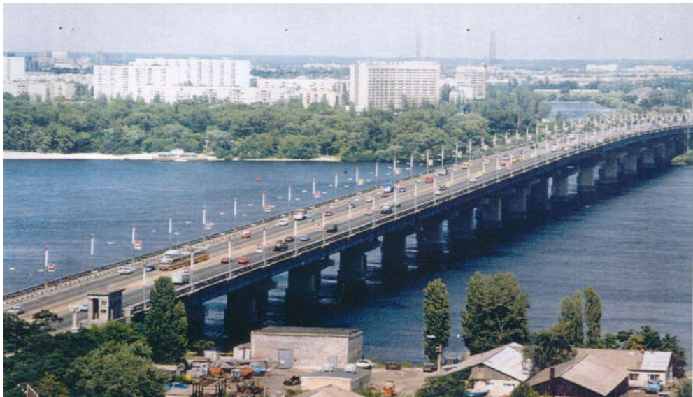
Рис. 3.1. Загальний вигляд моста ім. Є.О. Патона
