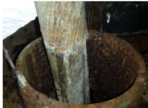
Рис. 2.6. Стан заанкерених канатів вантів для відтягування пілона
