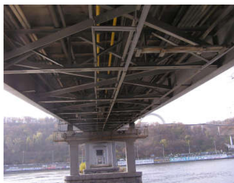
Рис. 9.9. Відсутній дерев'яний настил оглядових проходів
