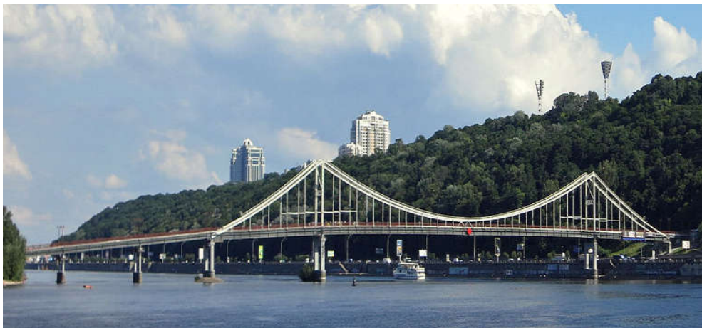
Рис. 11.1. Загальний вигляд Паркового моста через р. Дніпро в м. Києві
