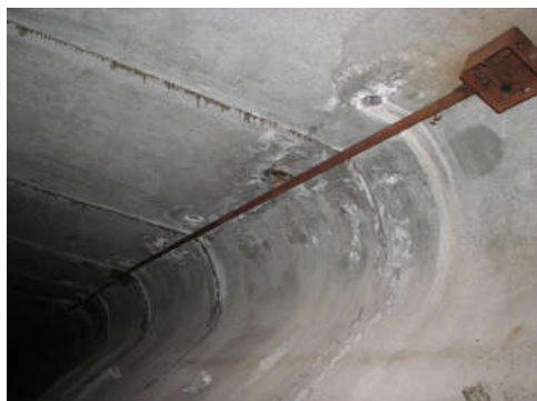
Рис. 3.4. Вилуговування бетону елементів залізобетонних прогонових будов
