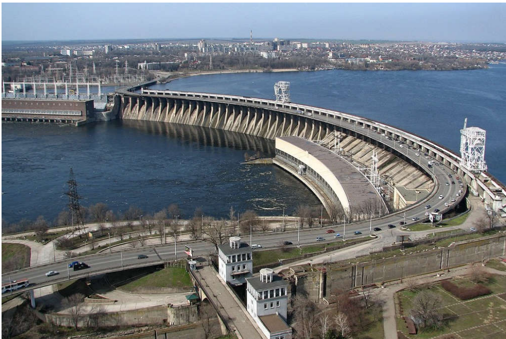
Рис. 1.37. Автодорожній перехід по спорудах греблі ДніпроГЕС
