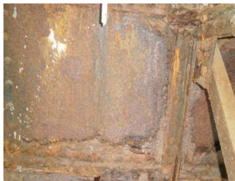
Рис. 3.4. Корозія головної балки у прогоні № 30-31
