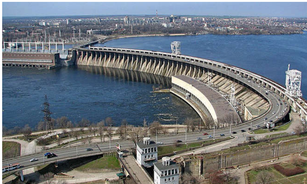
Рис. 1.57. Загальний вигляд автодорожнього проїзду спорудами греблі ДніпроГЕС
