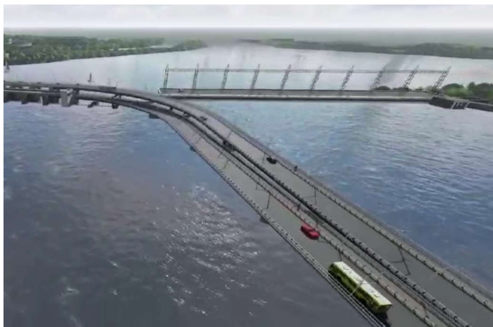
Рис. 2.34. Вид зверху моста через аванкамеру
