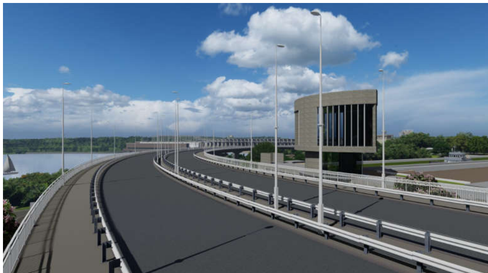
Рис. 2.40. Вид із проїзної частини естакади через шлюзи
