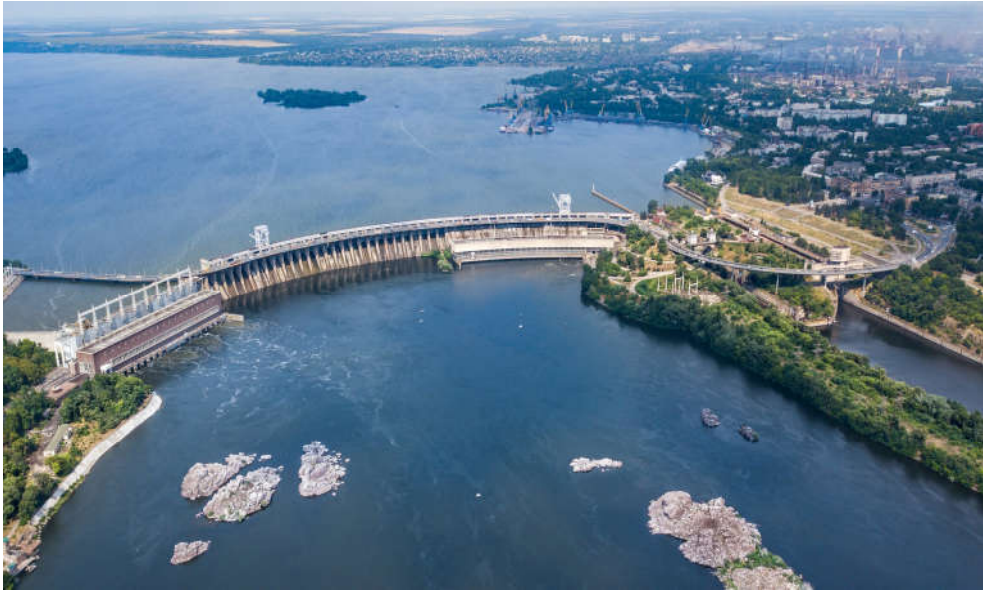
Рис. 1.27. Автодорожній перехід по спорудах греблі ДніпроГЕС
