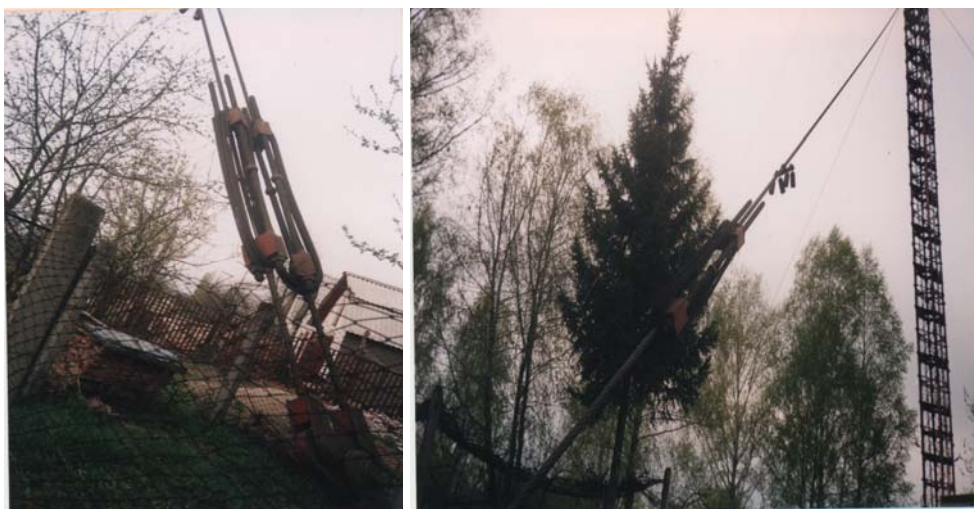
Рис. 10.5. Дефектные неподвижные траверсы стяжных муфт
