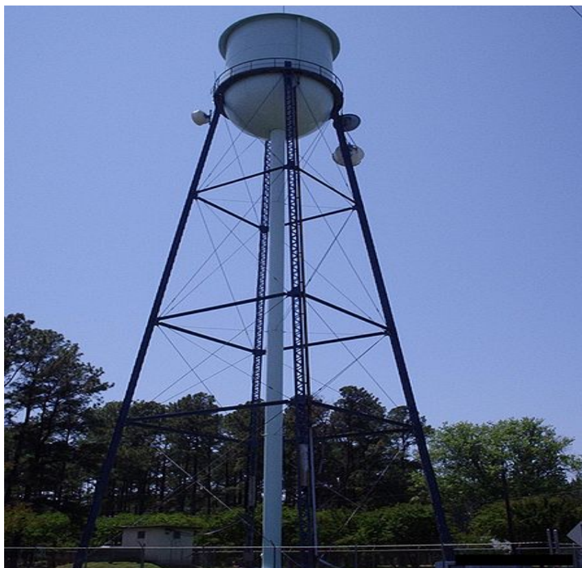
Рис. 1.29. Общий вид типичной водонапорной башни
