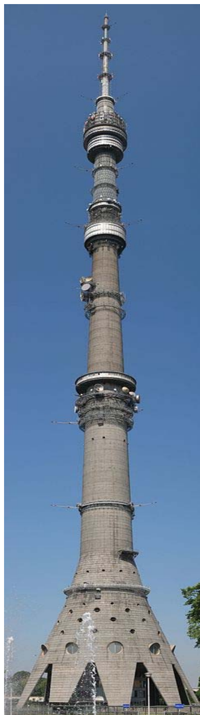
Рис. В.2. Телебашня Останкино в г. Москве высотой 540,1 м
