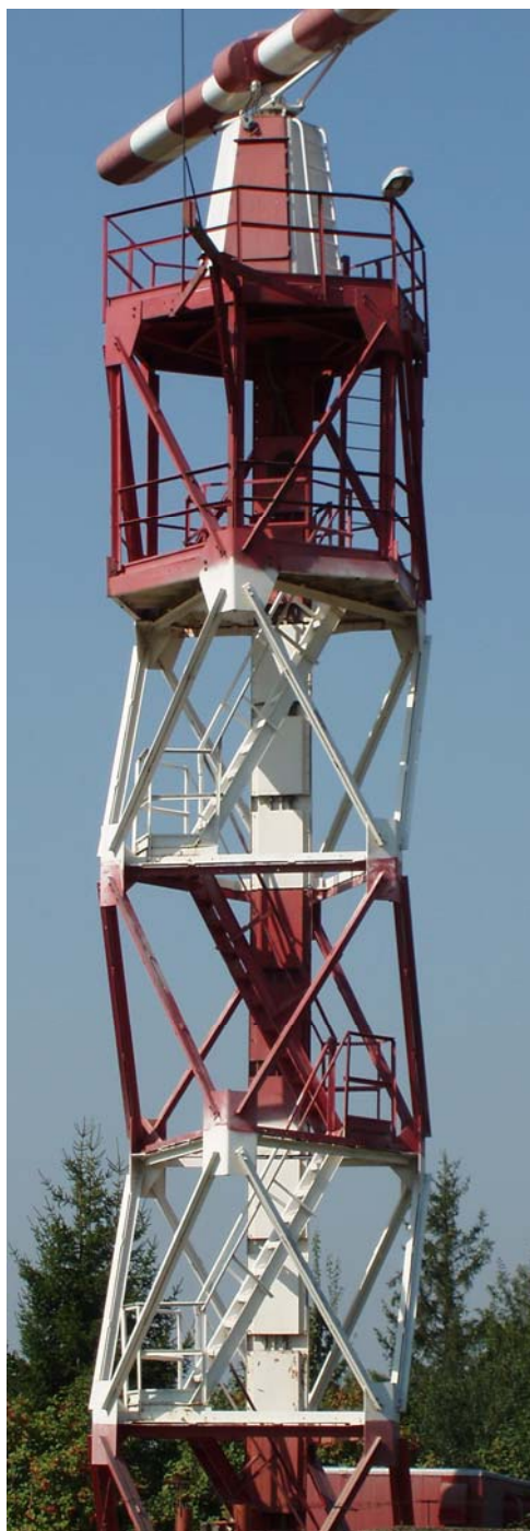
Рис. 1.21. Общий вид беспоясной башни
