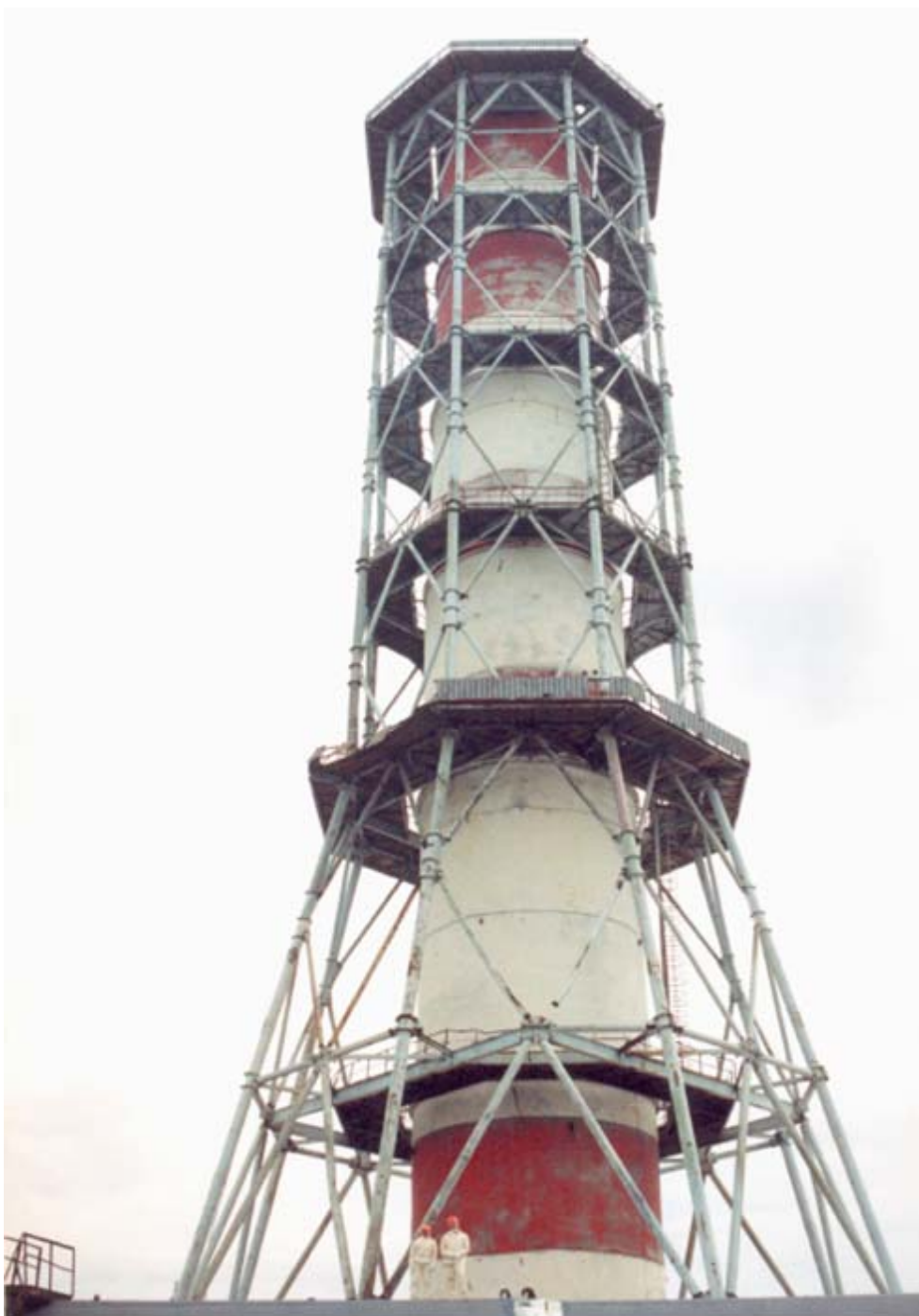
Рис. 1.26. Вентиляционная башня-труба 3-го и 4-го энергоблоков Чернобыльской АЭС (снимок сделан в 1996 г. с крыши 3-го энергоблока во время обследования башни)
