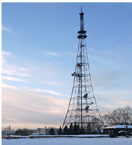
Рис. 1.13. Общий вид утилитарной телевизионной опоры высотой 192 м
