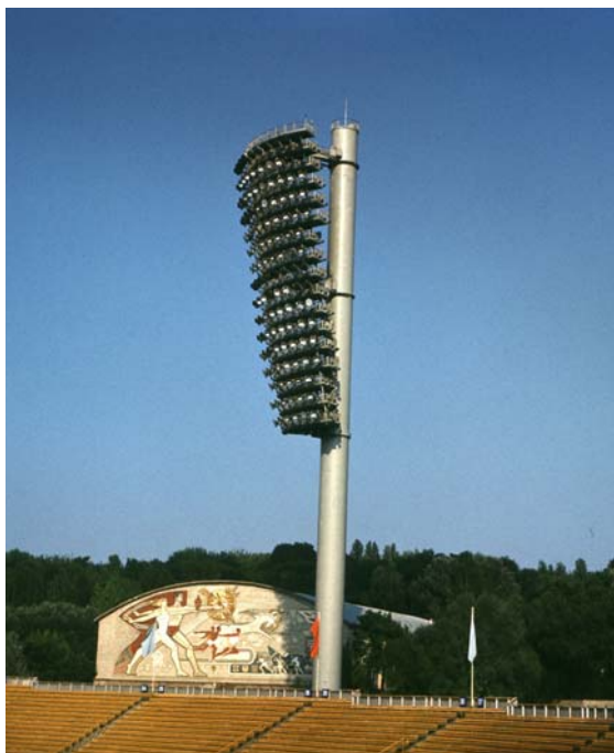
Рис. 3.1. Общий вид осветительной опоры стадиона Национального спортивного комплекса «Олимпийский» в г. Киеве
