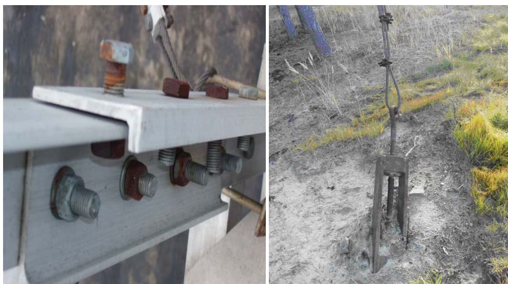
Рис. 10.9. Виды дефектов и работ при второй ( а ) и третьей ( б ) категориях реконструкции: а – узел башни (замена узловых металлических изделий); б – анкер мачты (замена оттяжек и анкерных фундаментов)
