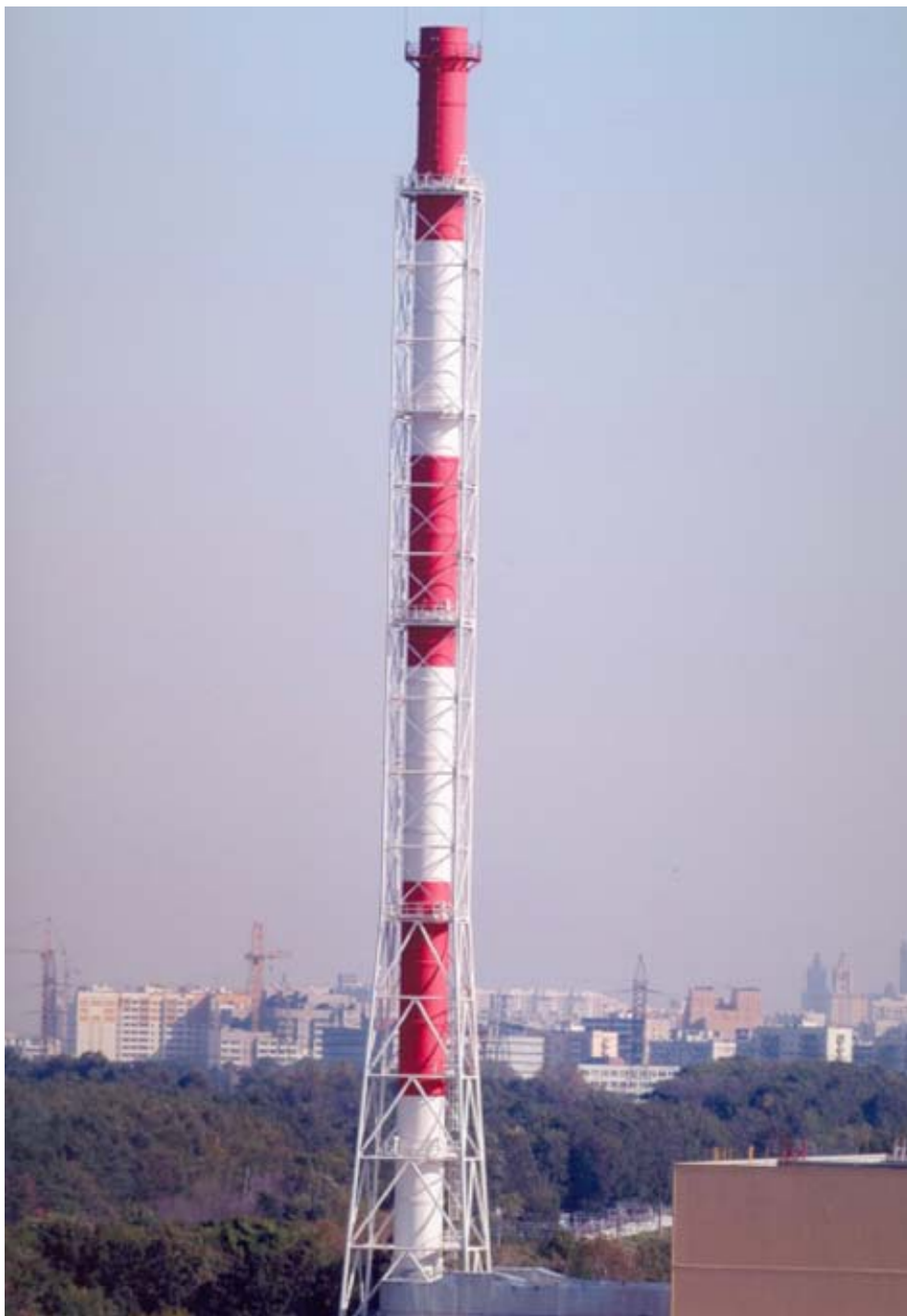
Рис. 1.27. Вытяжная башня-труба для химического завода в г. Терешково (Россия)
