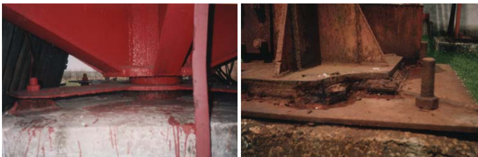
Рис. 10.6. Дефекты опорных узлов: а – мачты; б – башни
