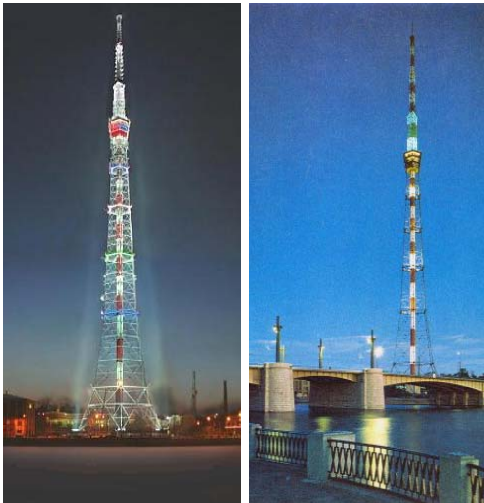
Рис. 1.3. Общие виды башни телевизионного центра в г. Санкт-Петербурге
