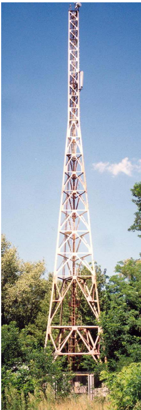
Рис. 1.20. Общий вид трехгранной башни для антенн мобильной связи
