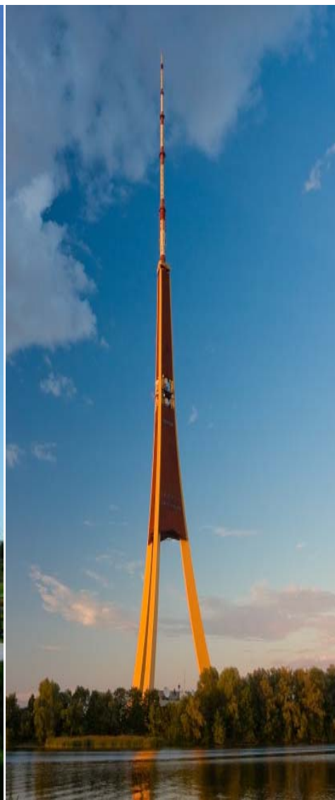
Рис. 1.12. Общий вид телевизионной башни в г. Риге
