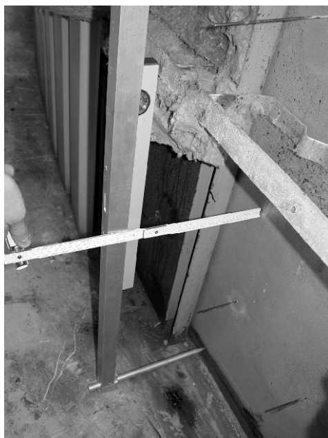
Рис. 3. Вид нижнего пояса внутреннего корпуса резервуара с демонтированной термической изоляцией
