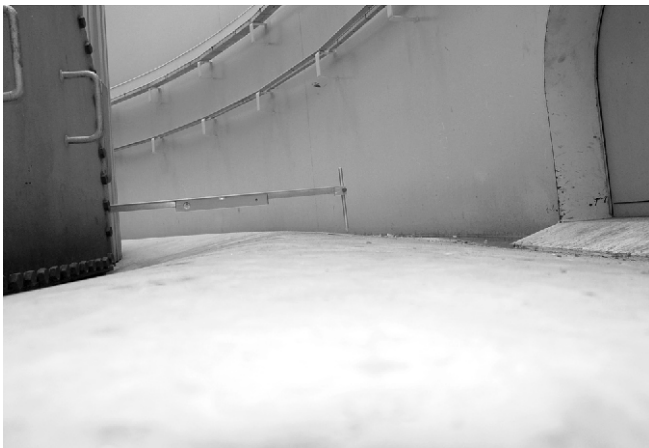
Рис. 1. Види деформації дна між стенками резервуара
