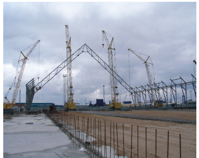
Рис. 7. Монтаж каркаса складу
