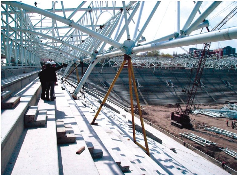
Рис. 13. Опорні стійки ферм
