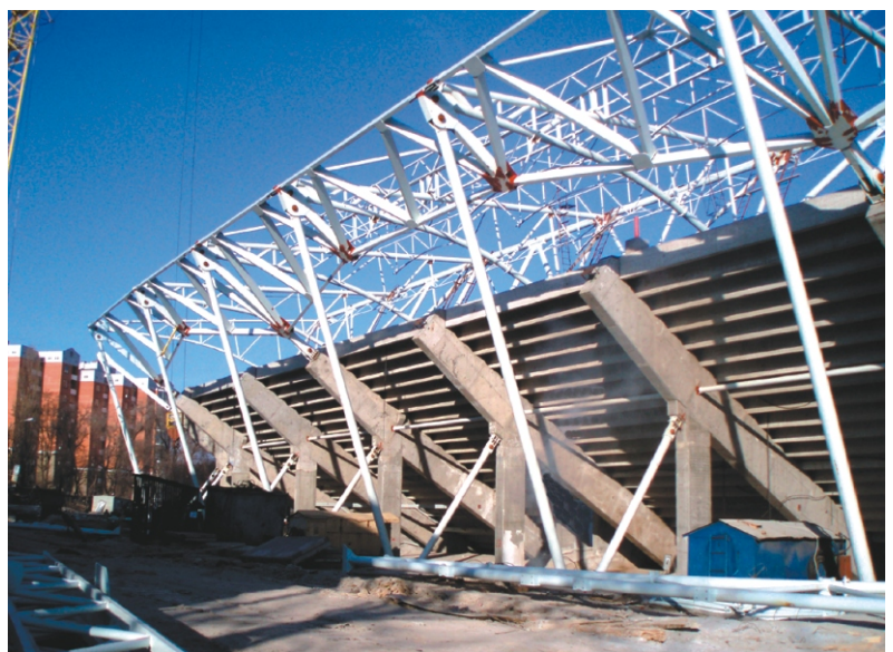
Рис. 14. Система закріплення несучих ферм
