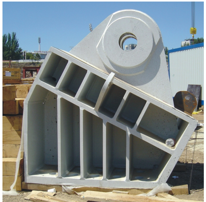
Рис. 6. Схема опорного вузла просторових радіальних ферм і загальний вигляд його верхньої закладної деталі
