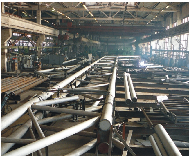
Рис. 6. Контрольне складання поперечної рами каркаса
