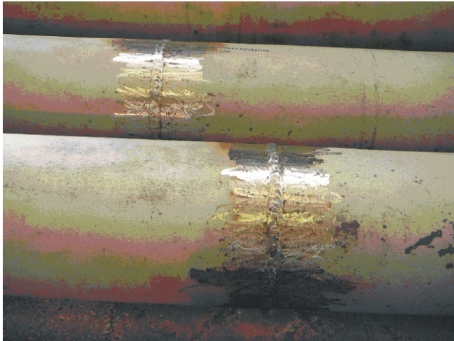
Рис. 4. Стик трубчастих елементів на підкладному кільці: а – загальний вигляд; б – принципова схема
