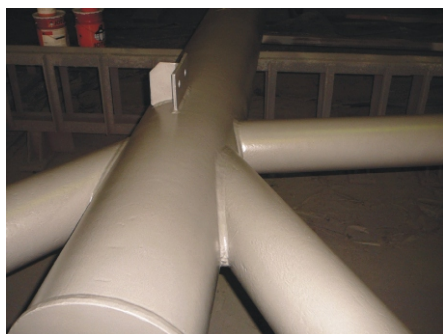
Рис. 3. Безфасонний вузол поперечних гратчастих рам складу
