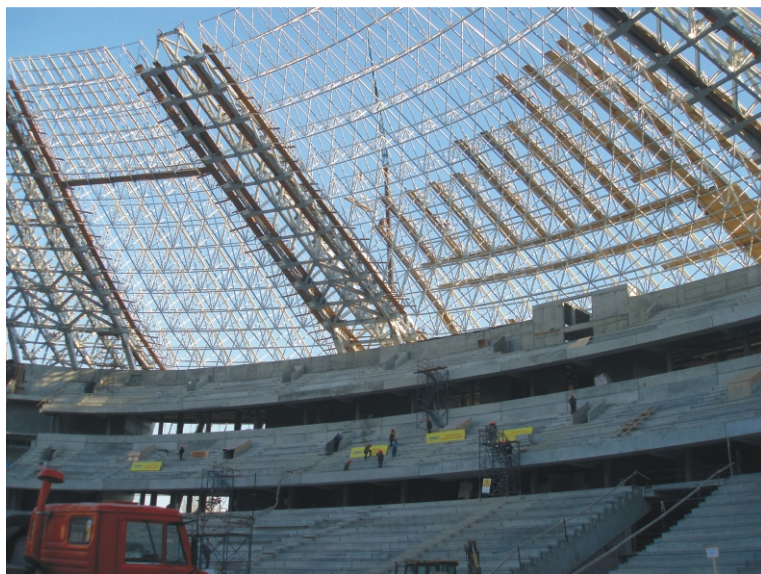
Рис. 7. Змонтовані просторові радіальні ферми і структурні блоки покриття
