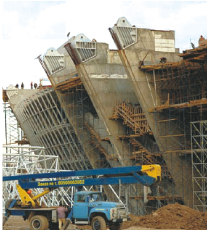
Рис. 5. Вузли обпирання радіальних ферм покриття
