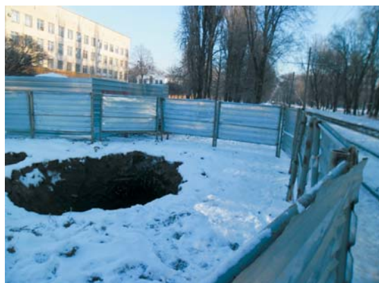
Рис. 8. Обрушения в зоне повреждения коллектора после засыпки грунтом первичного проседания грунта
