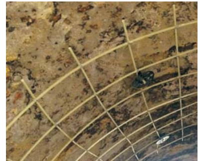
Рис. 24. Армирование стеклопластиковой арматурой сводовой части коллектора
