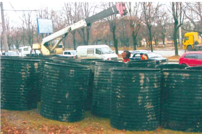
Рис. 3. Короткие полиэтиленовые трубы \varnothing 1200 мм для введения по методу «Inliner» в коллектор \varnothing 1500 мм
