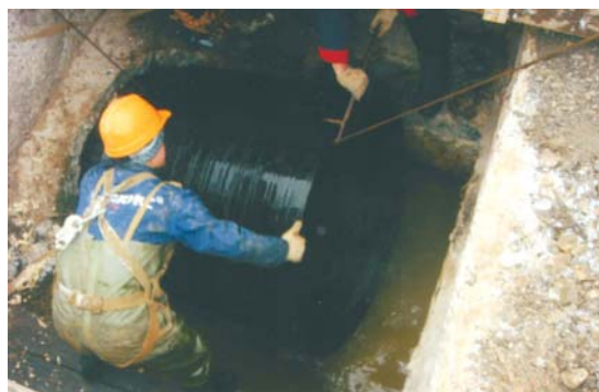
Рис. 5. Введение трубы в разрушенный трубопровод
