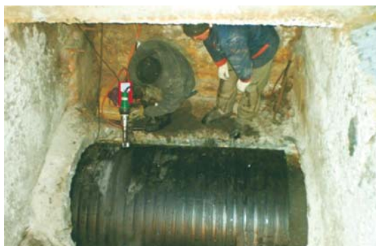
Рис. 6. Сварка коротких труб
