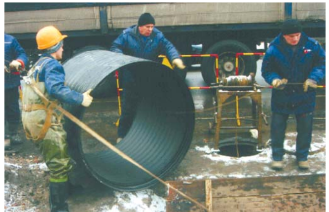
Рис. 4. Подача трубы во временную шахту
