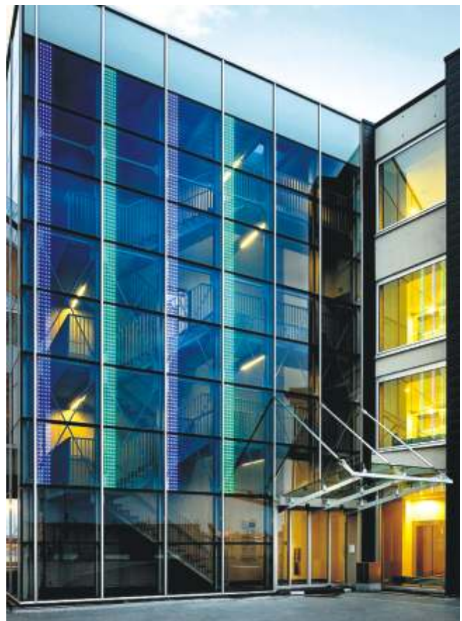
Встановлення світлоелементів у формі відбивачів або голографічних модулів між поверхнями скляних подвійних фасадів
