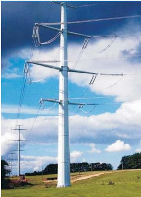
Рис. 1. Опора на основе МГС ВЛ 220 кВ с перспективной модификации в трубобетонную
