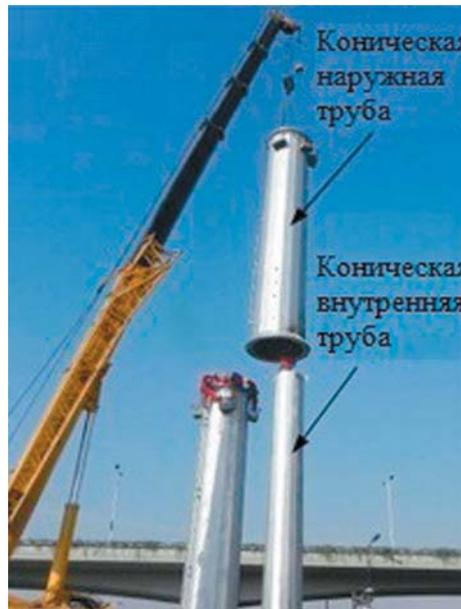
Рис. 4. Монтаж трубобетонной опоры с двойной оболочкой (Норвегия)
