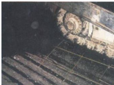
б) базальтопластиковая и стеклопластиковая композитная арматура в дорожном строительстве
