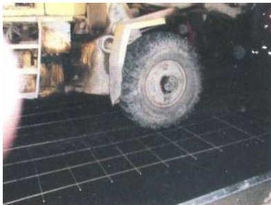
б) базальтопластиковая и стеклопластиковая композитная арматура в дорожном строительстве
