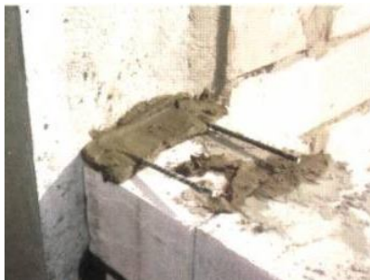
а) армирование стен стеклопластиковыми и базальтопластиковыми гибкими связями
