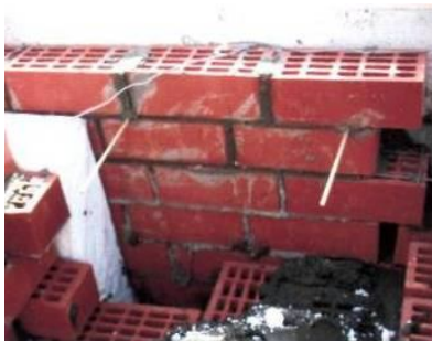
а) армирование стен стеклопластиковыми и базальтопластиковыми гибкими связями
