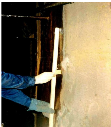
Рис. 1. Деформации конструкций доменной печи №3 в процессе эксплуатации: а) волнообразные деформации кожуха доменной печи вследствие его перегрева; б) деформации опорных стульчиков вертикальных газопроводов грязного газа вследствие их “просадки”
